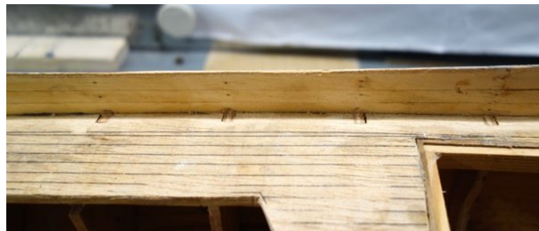
Über Deck wurden die Spanten mit einer elektrischen Säge vorsichtig abgetrennt
