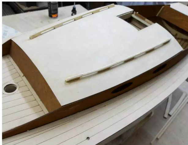
Der Handlauf wird an der vorher angezeichneten Position von unten verschraubt
