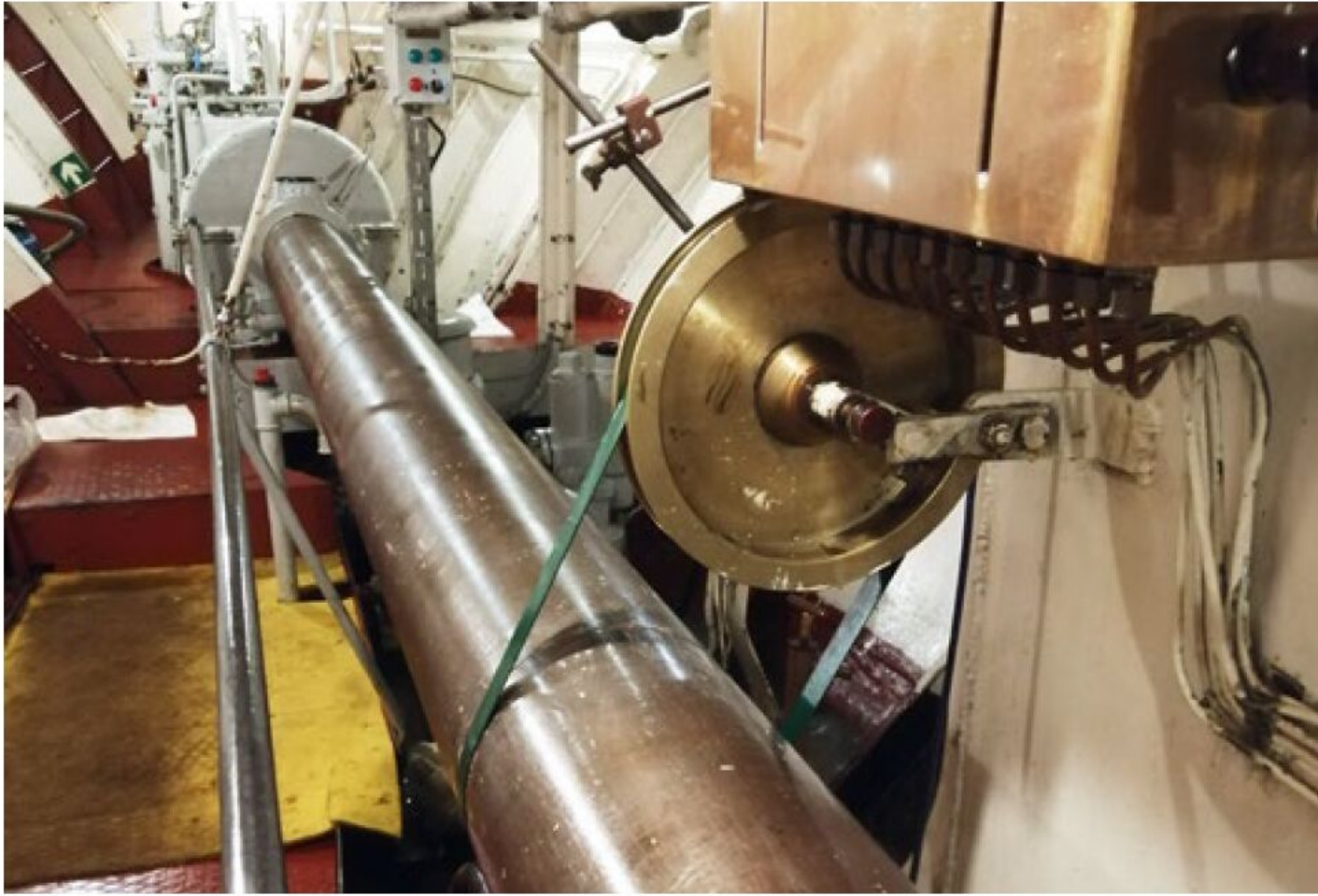
Im Heckbereich des Maschinenraums überträgt die Welle die Kraft auf den Propeller
