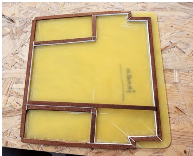
Der Grundrahmen des Teakholzdecks der Plicht entsteht
