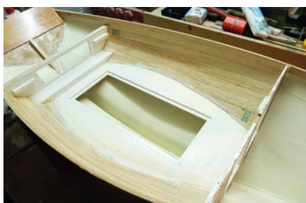
Die Schotten und Böden werden außerhalb des Rumpfes zusammengebaut, bevor sie an Ort und Stelle eingearzt werden
