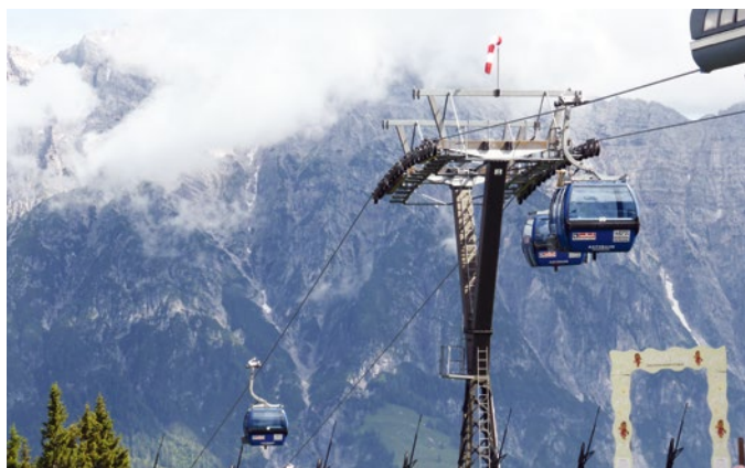
Seilbahn vor der Kulisse der Leoganger Steinberge
