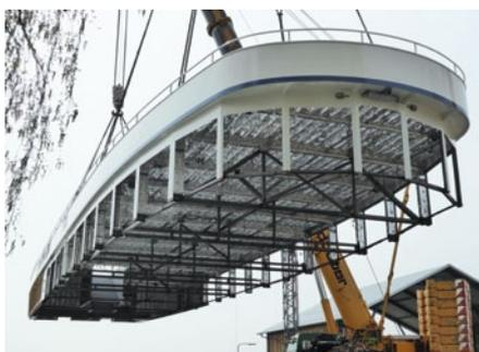
Der lange Aufbau wird separat nach dem Absetzen des Rumpfs auf diesen aufgesetzt
