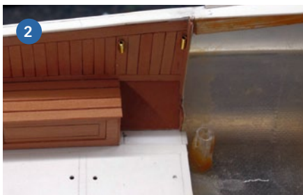
1) Damit die Treppen sicher an ihrer Position verbleiben, halten Messingstifte, die in Röhrrchen greifen, diese fest. 2) Hier zwei Messingröhrrchen zum Fixieren der Treppe
