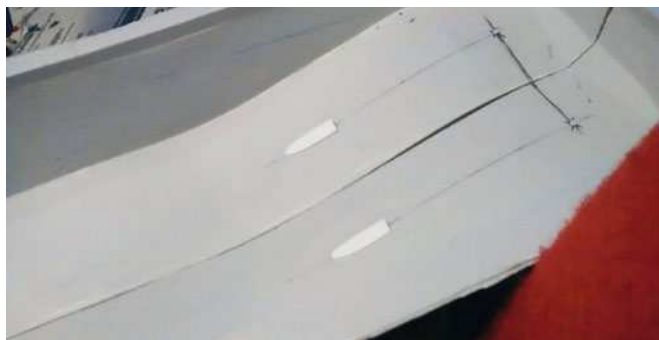
In die Negativform wurden die Stellen mit etwas Polystyrol „erhaben“ markiert, an denen später die Ankertaschen sitzen oder so wie hier, sich die Wellenausstritte befinden
