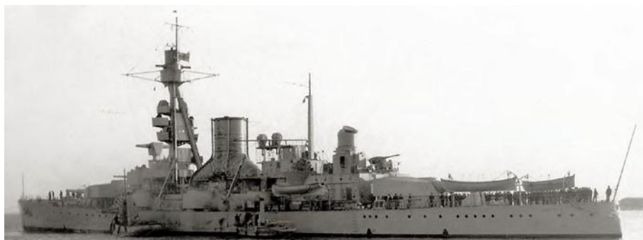
Bei der GUSTAF V wurden beide Kamine zu einem Rauchabzug zusammengefasst. Beim Kampfeinsatz sind die hintersten Beiboote von Bord gegeben und die Davits auf Deck gelegt
