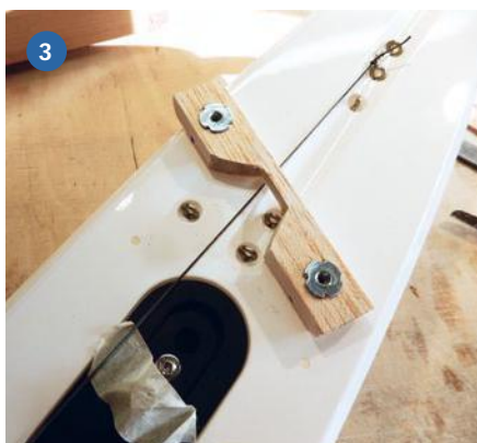
... nachdem das Deck von unten verstärkt wurde
