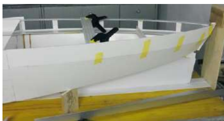
Die Spitze wurde von oben nach unten gebaut, in der Mitte sieht man die Führungsschiene für einen geraden Aufbau
