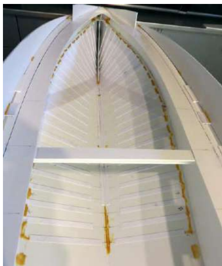
Der vordere Teil wird schrittweise mit 50 Millimeter breiten ABS-Streifen ausgekleidet
