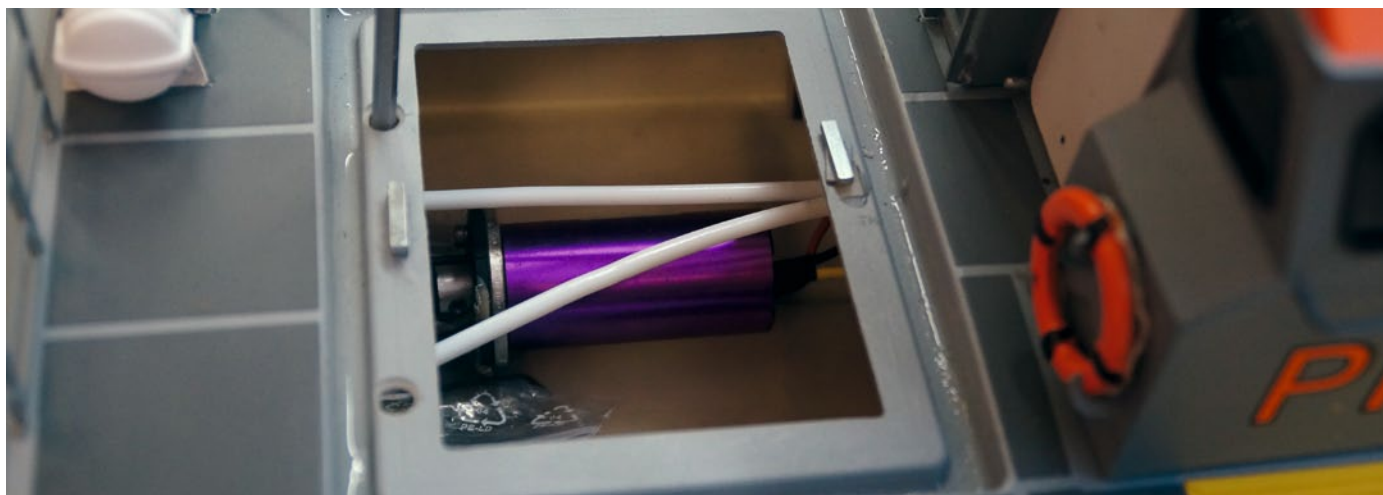
Zugang zur Wellenkupplung, um die Madenschraube festziehen zu können
