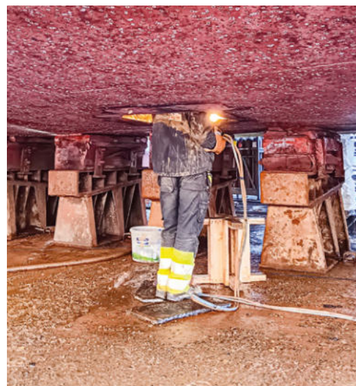
▼ In den Schiffsboden sind Arbeitsöffnungen geschnitten, um einige im Doppelboden liegende Tanks reinigen zu können
