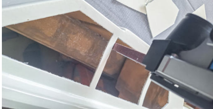
Die Schnittkanten wurden mit einer elektrischen Feile verputzt
