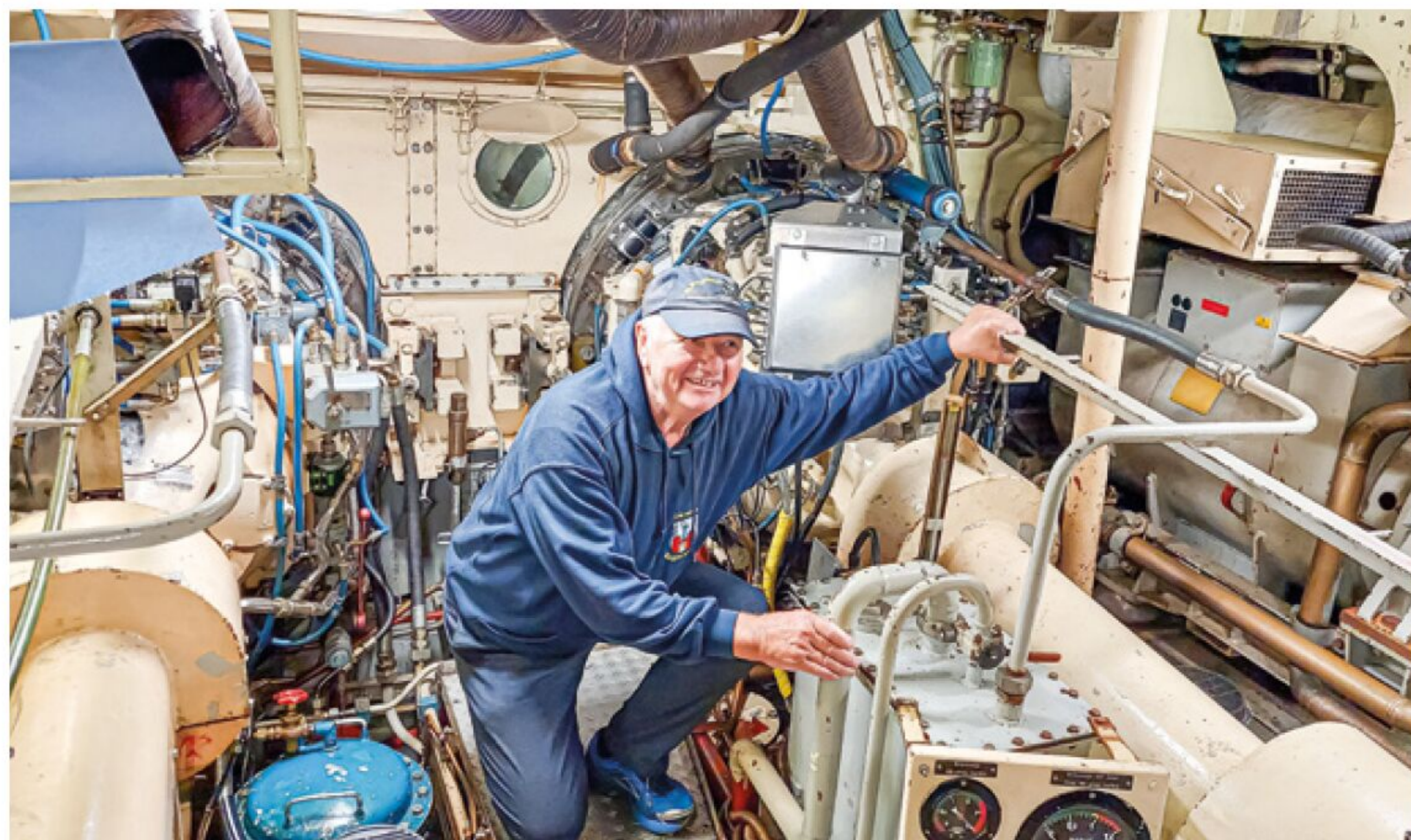
Blick in den Turbinenraum, dem Herz der Spica
