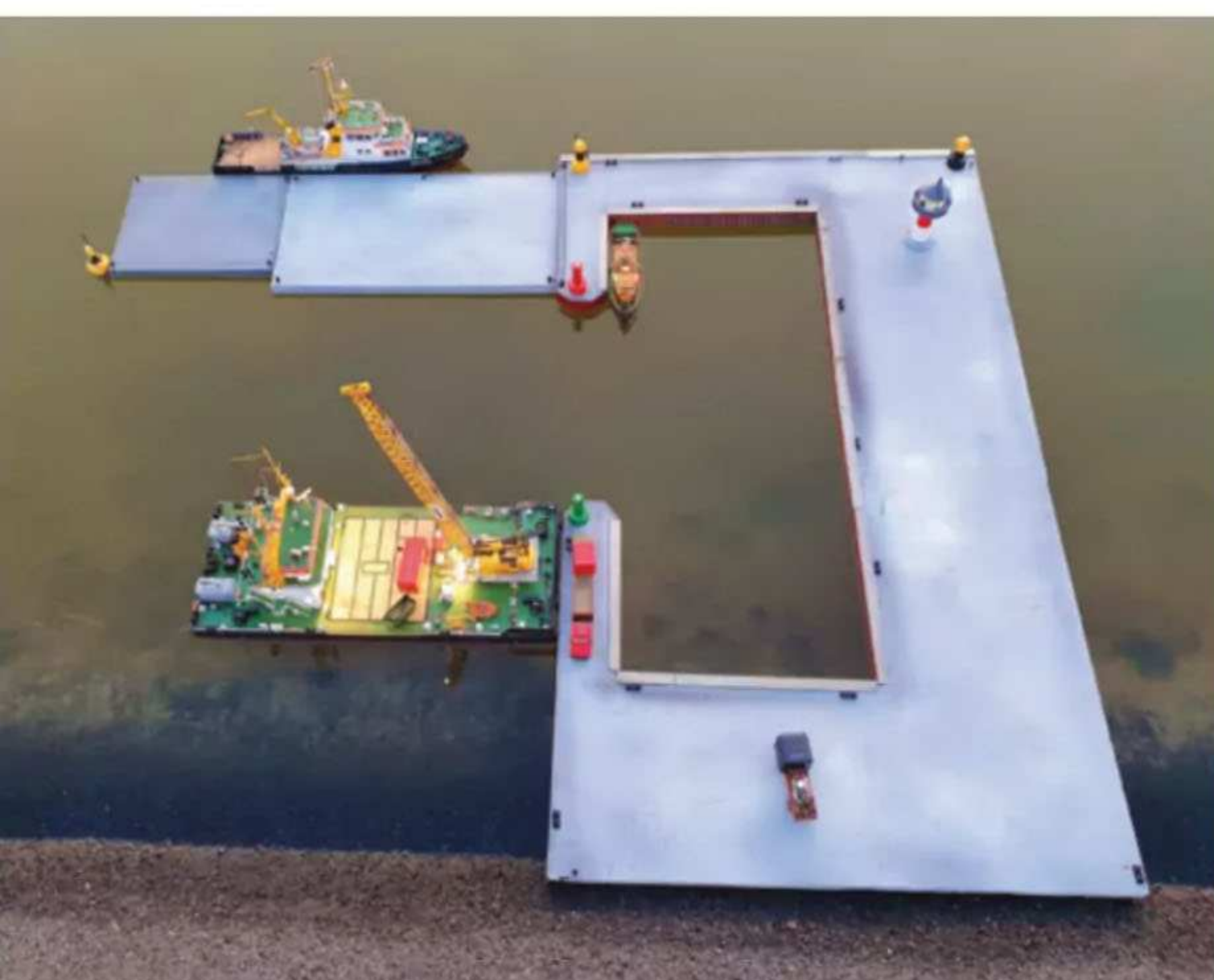
▲ Ein Stück Hafen und zwei Pontons sind in Betrieb
