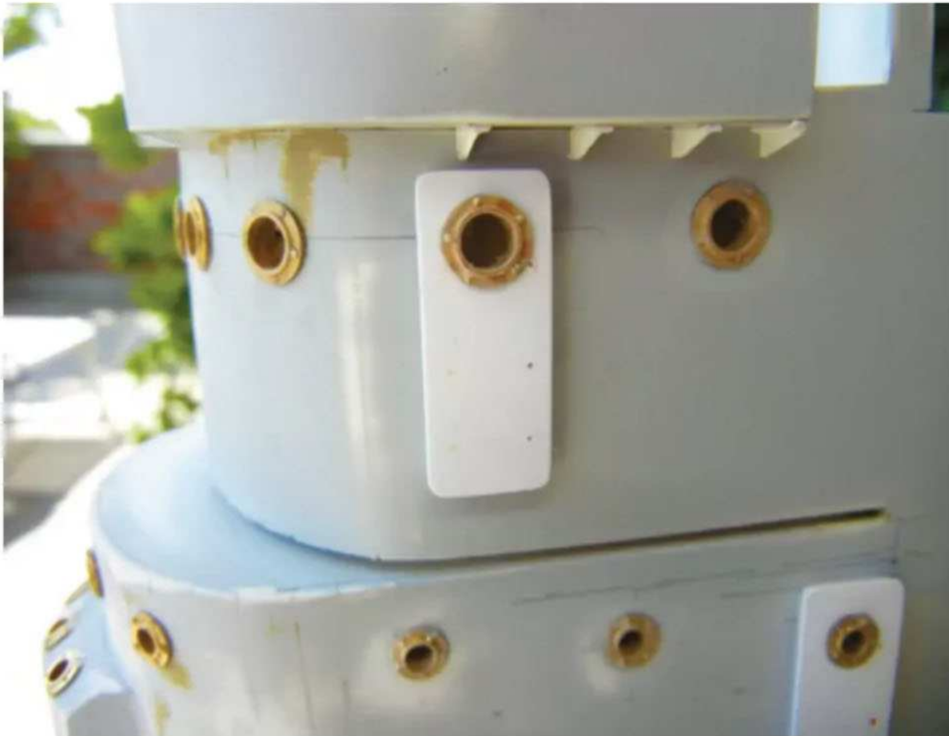
Türen und Bullaugen am Aufbau. Bei den Bullaugen galt es, rund 150 Nieten zu setzen
