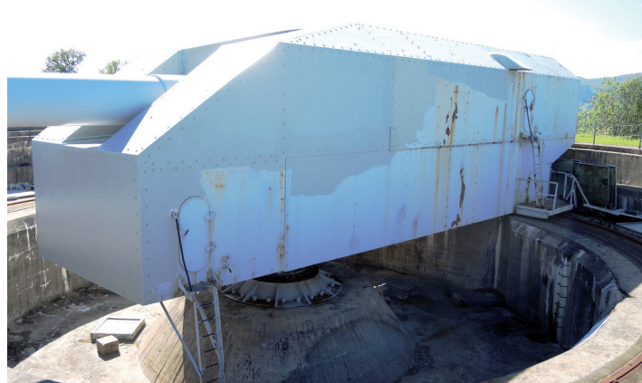
Blick in den betonierten Barbetteunterbau von Turm „Barbara“
