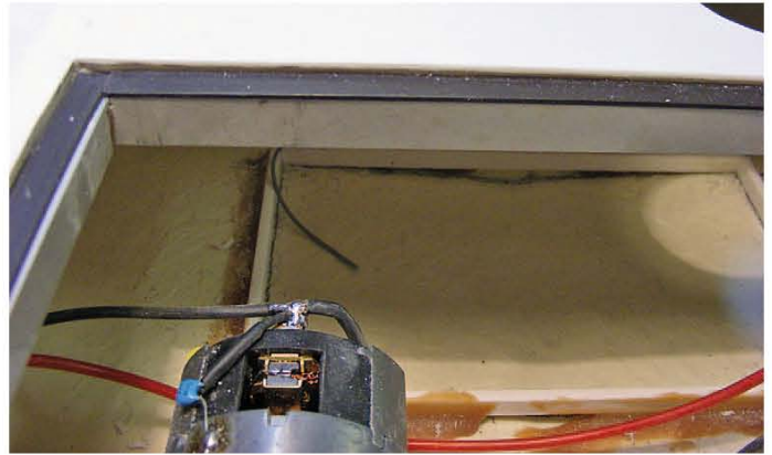
Alu-Profile mit Magnetband tragen das Deck an der Hauptöffnung
