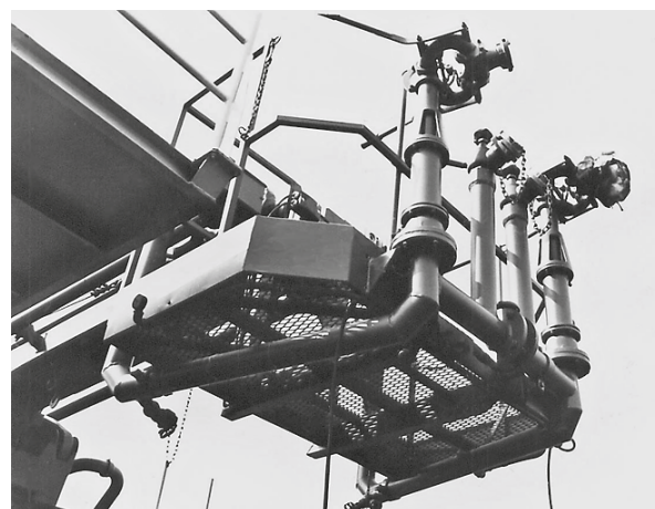
Die Plattform am Hubsteiger von unten. Die Strahlrohre sind abgebaut (Foto: Siegfried Borchert)
