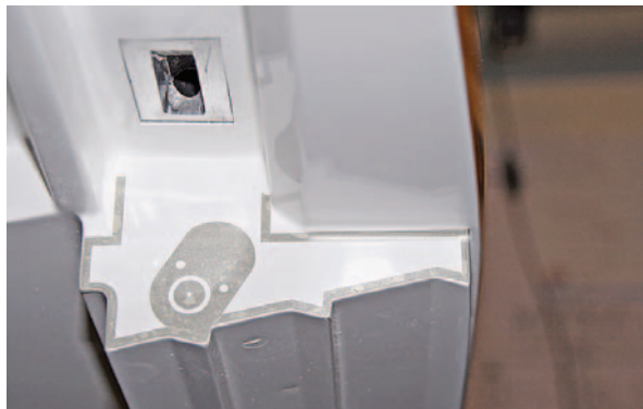
Die Position für die Stevenrohr-Durchführung ist angerissen
