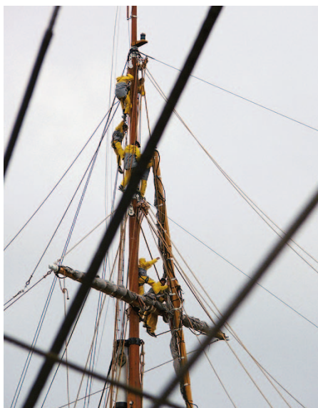
Im Großmast, genauer an der Bramstenge, wurde gearbeitet
