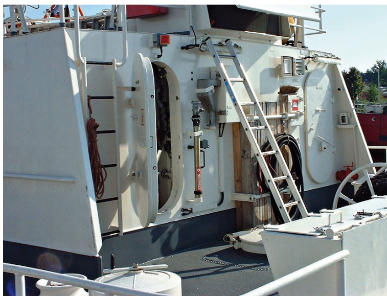
Rückwand des langen (Aluminium-)Deckshauses. Die gezurrten Bretter in der Mitte sind Leckwehrrbretter. Foto: Klaus Dieter Rex
