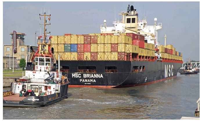
In Antwerpen ist die größte Schiffsschleuse der Welt zu besichtigen
