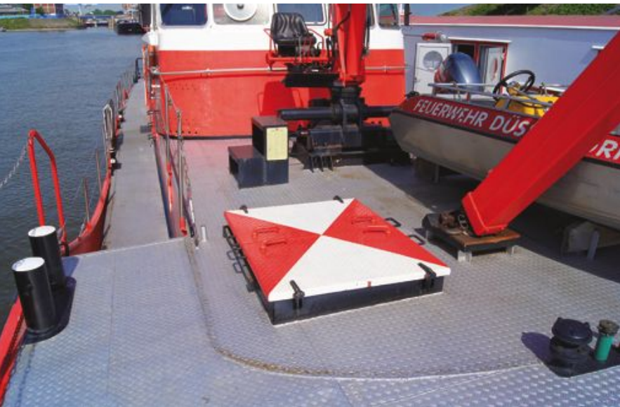
Die Schweißnaht an der alten Position des Deckaufbaus
