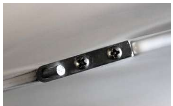
Das Ruderlager ist bereits verschraubt
