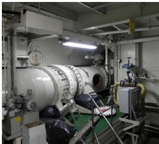
Die Rohrverbindung der Krängungsanlage zwischen den Pumpen und den Tanks. Das System hat einen Durchmesser von 1.300 mm, somit können die immensen Wassermengen bewältigt werden
