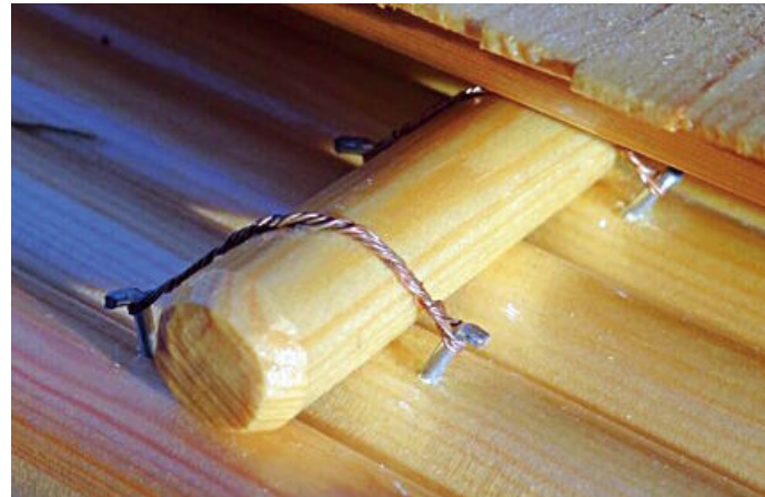
Die Stämme sind mit verzinktem Draht mit den Aufbündrohren verbunden
