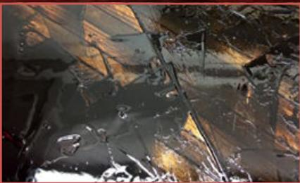
Ausgegossene Fugen mit schwarzem Epoxid
