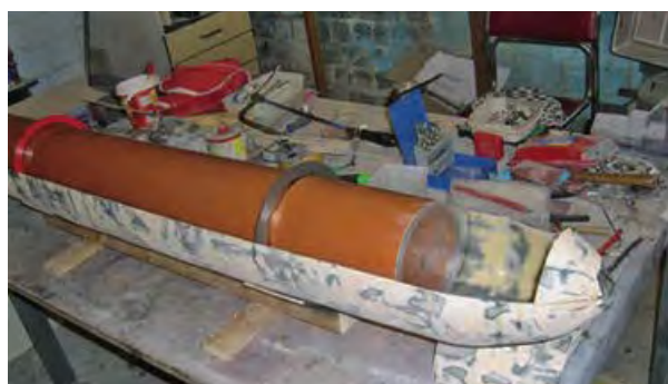
▲ Einbau des KG-Rohres als innere Hülle
