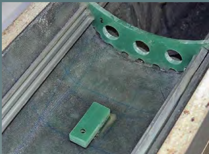
▲ Die in das Oberdeck eingebauten Spanten
