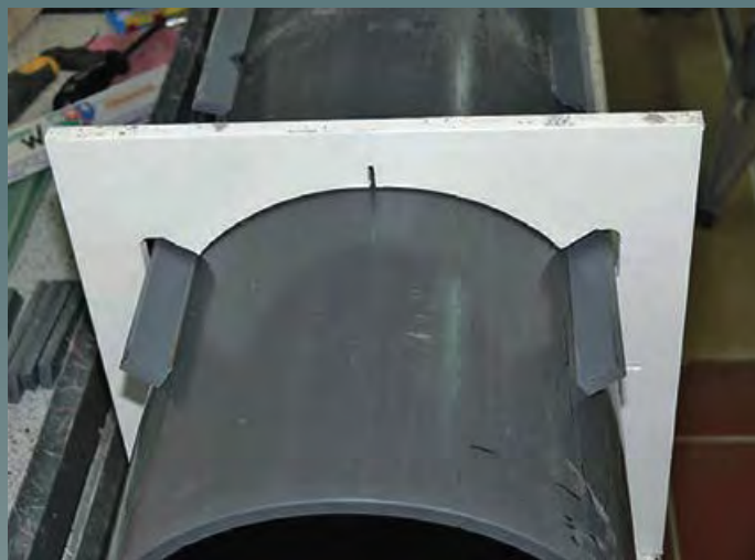
▲ Unterkonstruktion zur Montage der FSA
