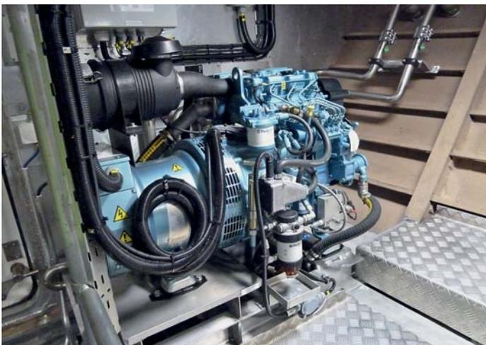
Der Stromgenerator; er springt automatisch an, wenn die Stromversorgung zum Land gekappt wird
