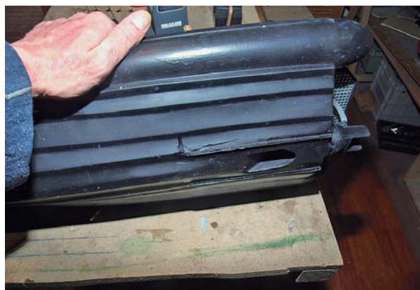
Leitstringer am Jet-Einlass des RIBs
