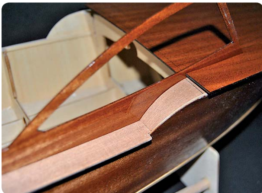
Einbau der Rundung
