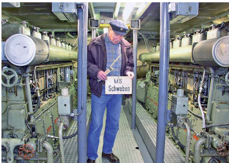
Auch der Maschinenraum des Originals wurde inspiziert
