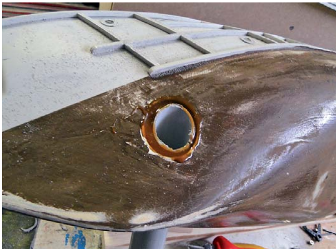
Das neue Rohr des Bugstrahlruders
