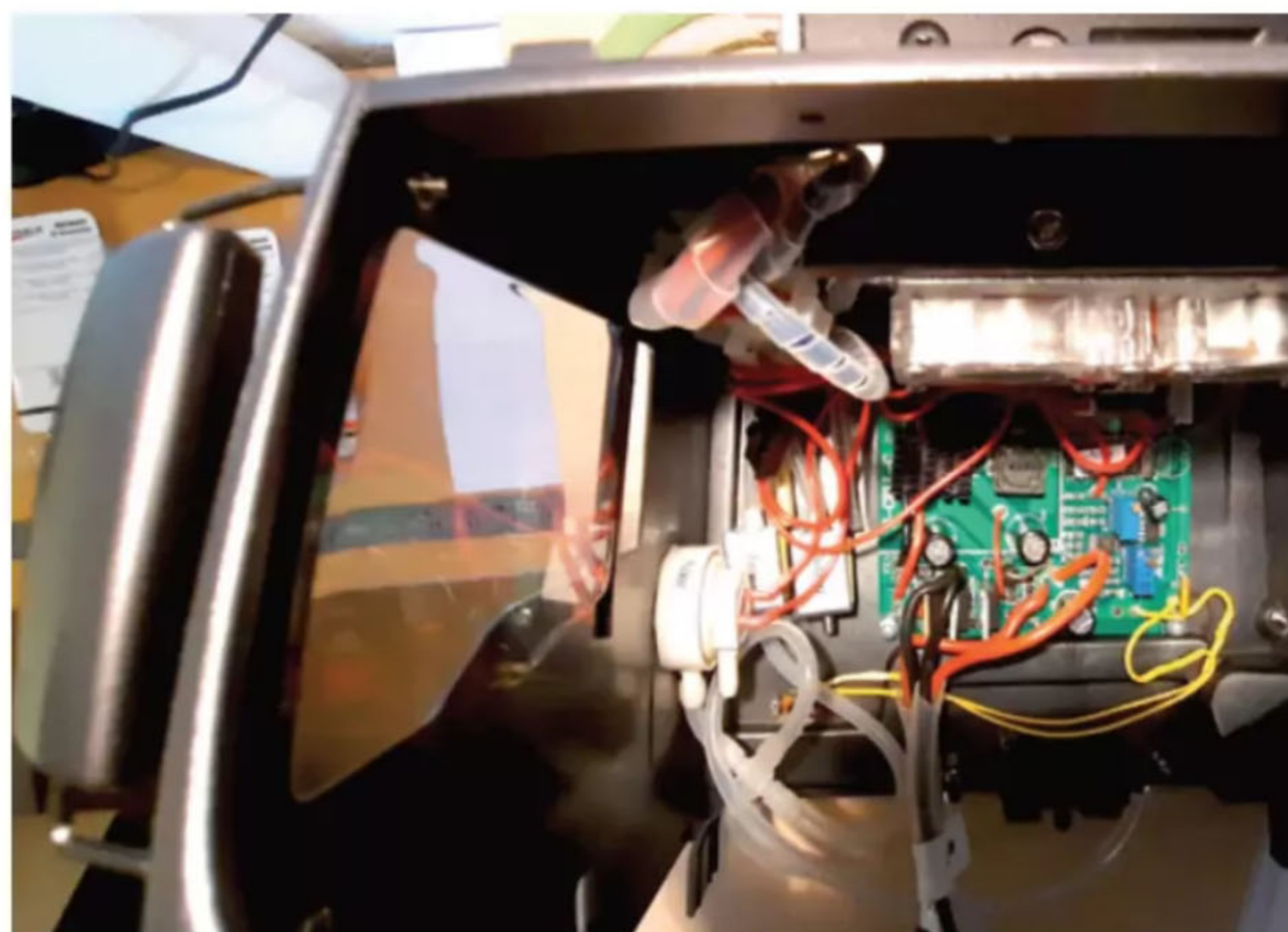
Die gesamte Technik wurde anders angeordnet, als normalerweise vorgesehen
