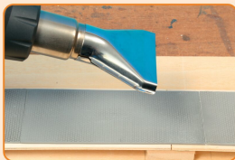
Das Aushärten der Pflasterstraßenstreifen erfolgt auf der Holzbasis mit dem Heißluftföhn.
