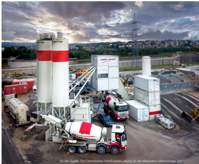
An der Quelle: Der Fahrmischer nimmt seine Ladung an der stationären Misanlage auf.
