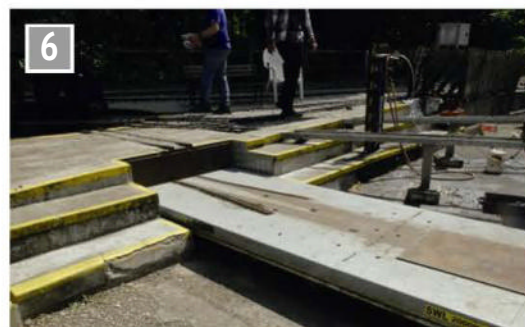
SSMEE loading ramp.
