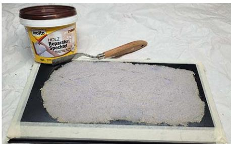
**19** Der Holzspachtel wird aufgebracht. Die Lösungsmittel lösen den Kunststoff leicht an, ein Haftgrund ist nicht notwendig
