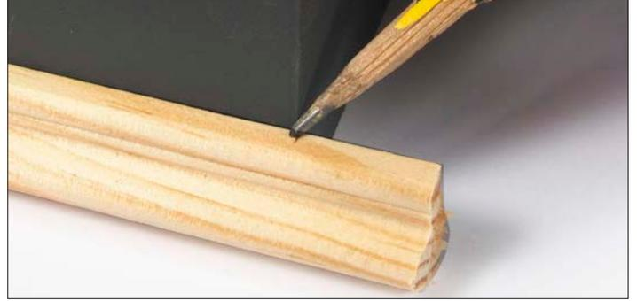
**10** Der Autor nutzt feine Profilleisten, um den Sockel noch etwas aufzuwerten. Zuerst wird die Länge bestimmt und mit Bleistift angezeichnet
