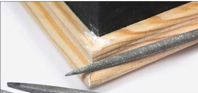
**15** Zum Füllen der Lücken kommt Acrylkitt zum Einsatz. Nach 24 Stunden Trocknung kann alles in Form geschliffen werden
