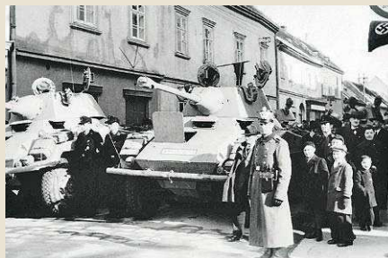
Sd.Kfz. 234/2 in Bruck an der Leitha (Österreich)
