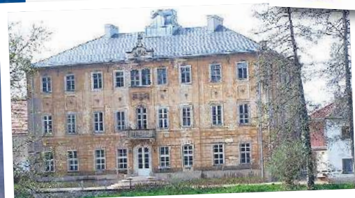
Das Gebäude vor der Sanierung
