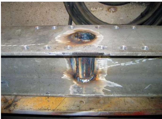
Die eingeschweißte Hülse
