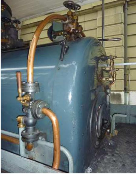
Der stehende Injektor im Detail zur Kesselwassereinspeisung
