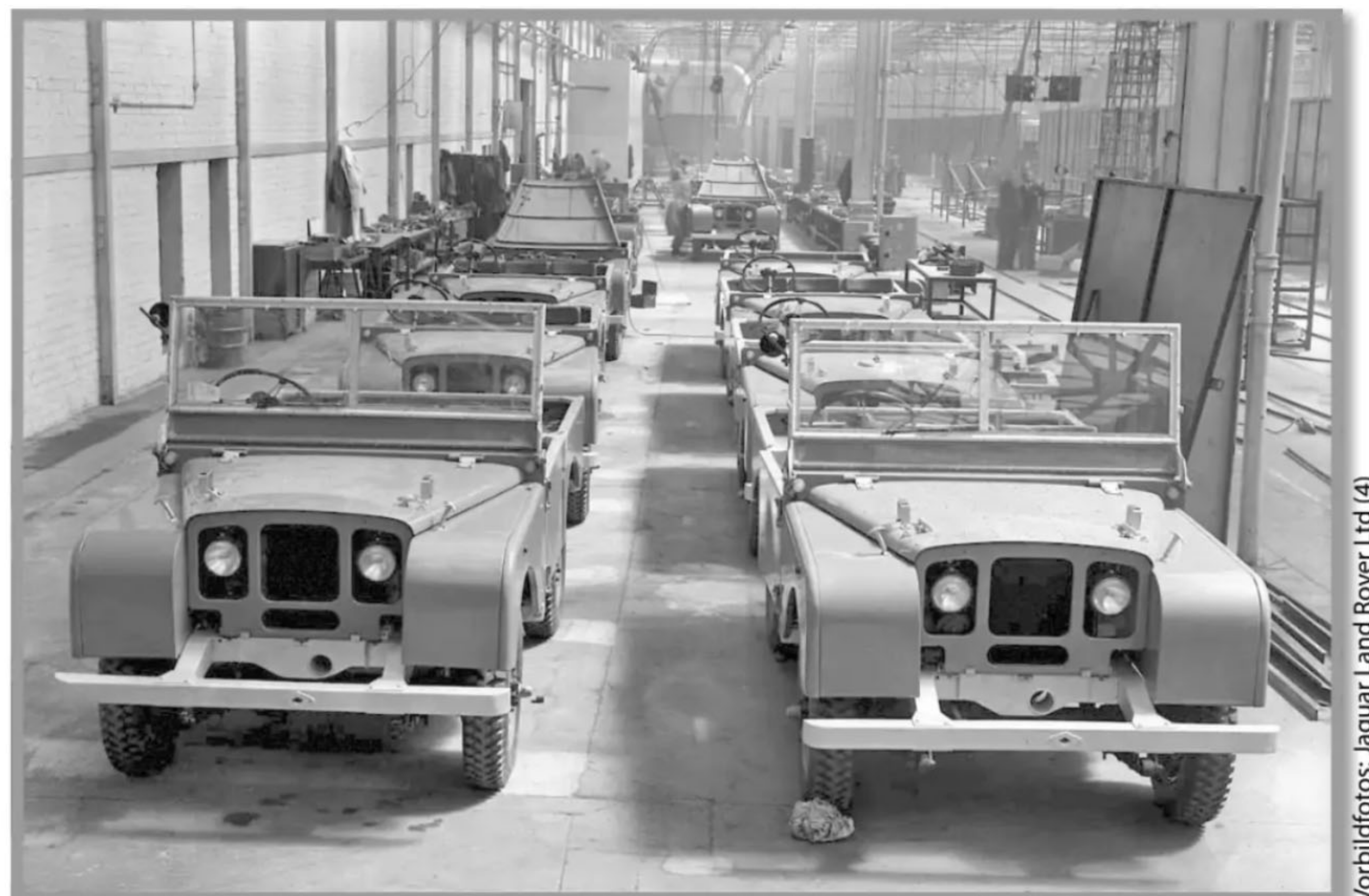
Frühe Fertigung anno 1949/50 im Werk Solihull. Fast fertige Fahrzeuge, noch ohne Grill und ohne Sitze.
