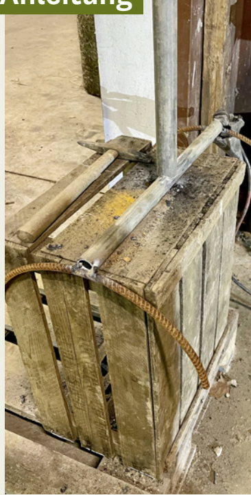
Der Unterbau ist fertig verschweißt und bereit für den Nistkasten.
