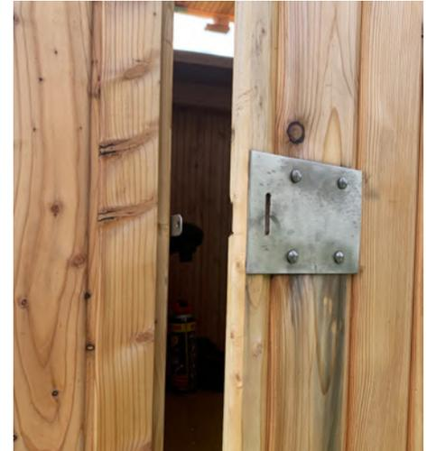
ne Metallstreifen unterzubauen, damit sich bei einem Aufbruchversuch von außen der Druck auf den Rahmen verteilt und nicht nur auf den schmalen Riegel konzentriert. Wer auf Nummer sicher gehen will, nimmt lieber einen Schubriegel mehr. ■
