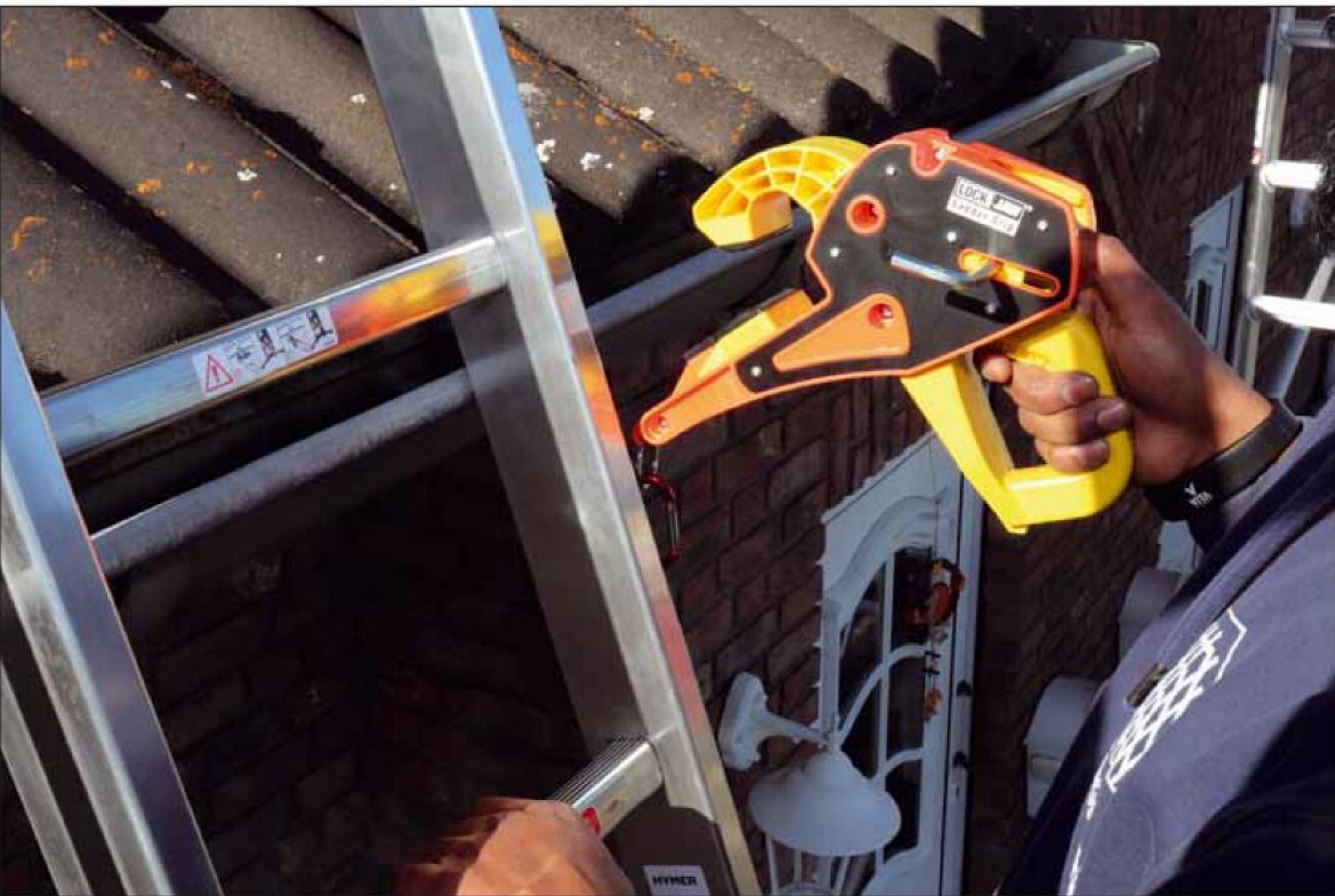
Zuerst wird die Sicherungsklaue offen an die Regenrinne angesetzt
