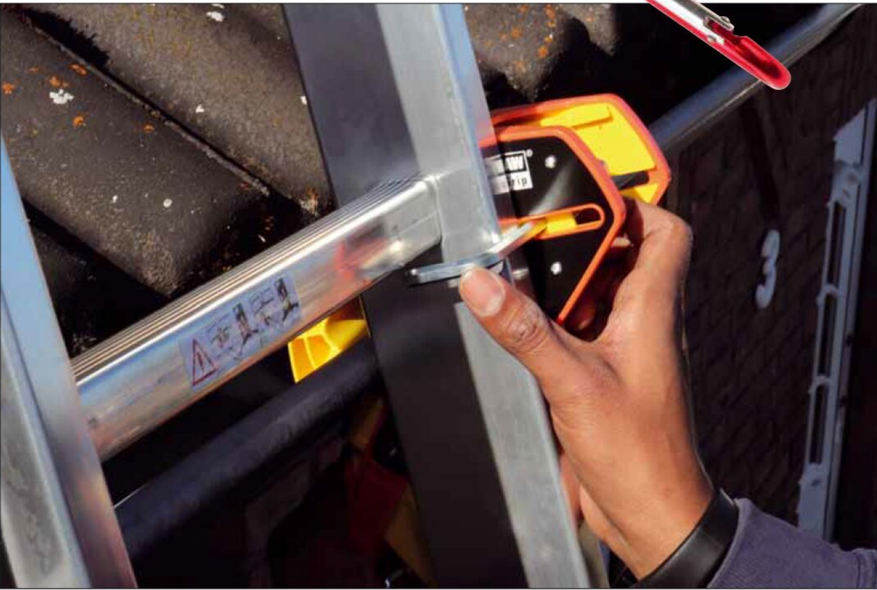
Jetzt wird nur noch der Leiterholm an der Klaue mit Hilfe des abgewinkelten Sechskants fixiert
