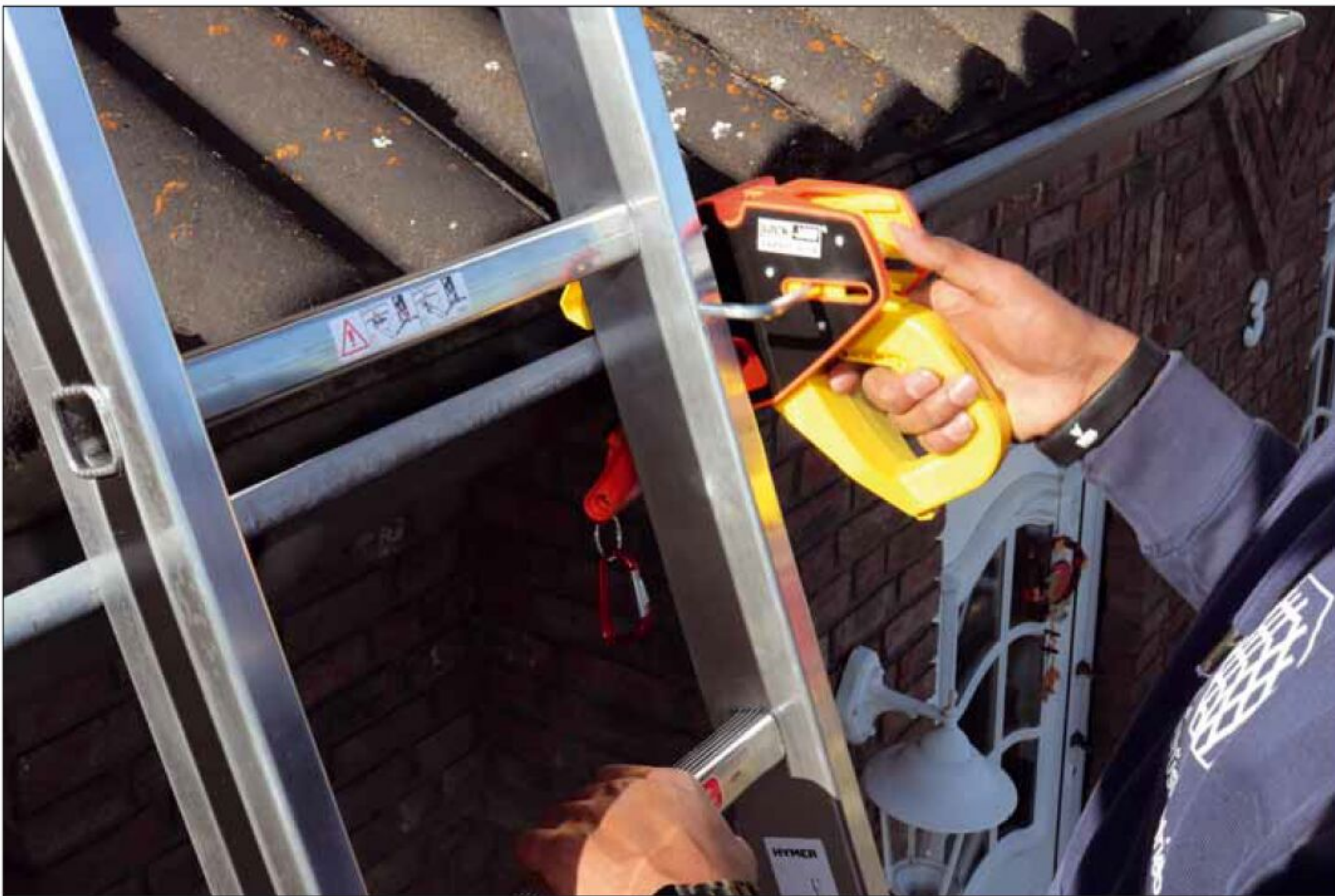
Durch die Betätigung der Arretierung im Griff setzt sich die Klaue an der Rinne fest
