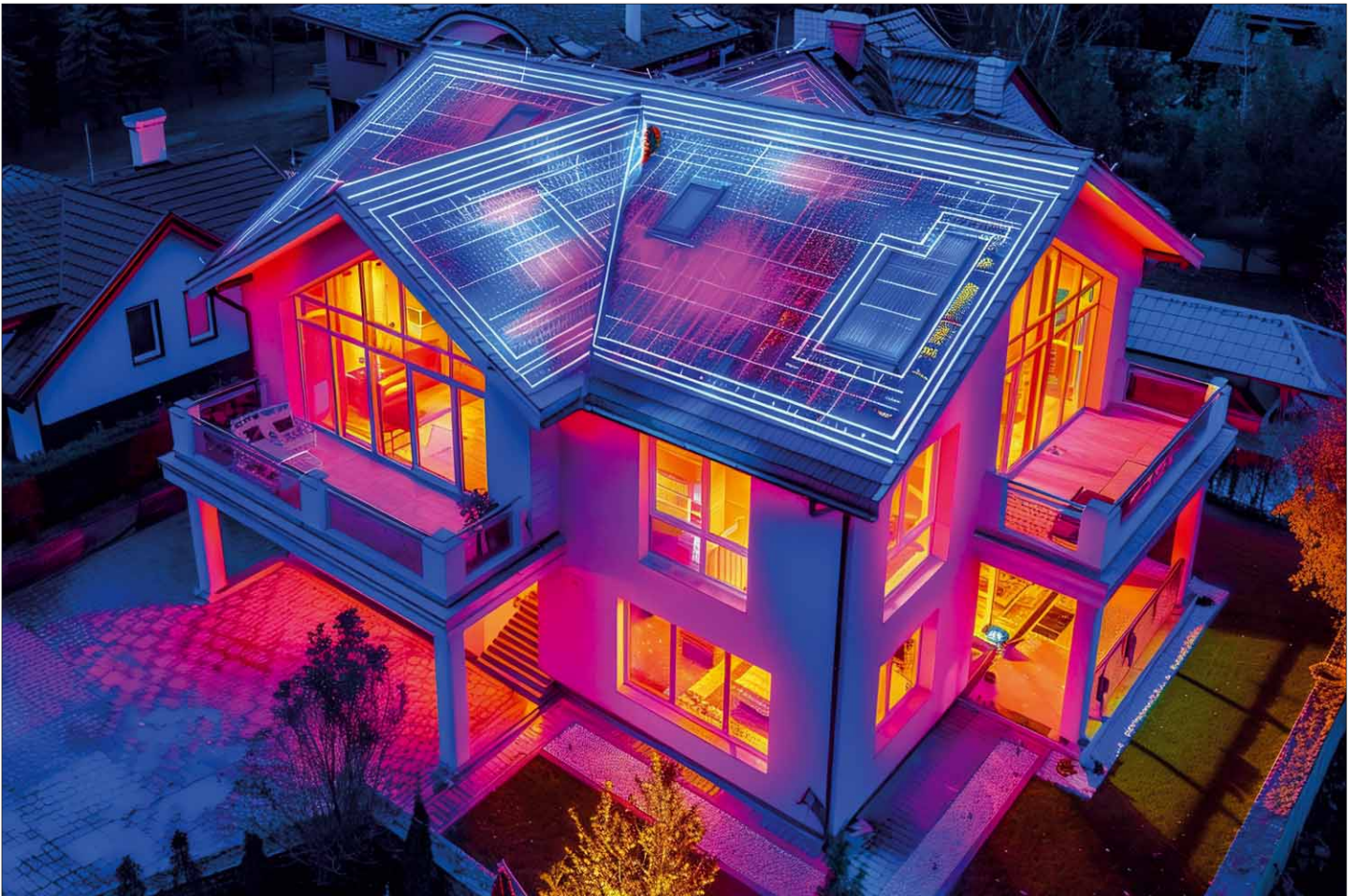
Je heller das Rot, desto mehr Wärme gelangt nach draußen bzw. geht verloren
