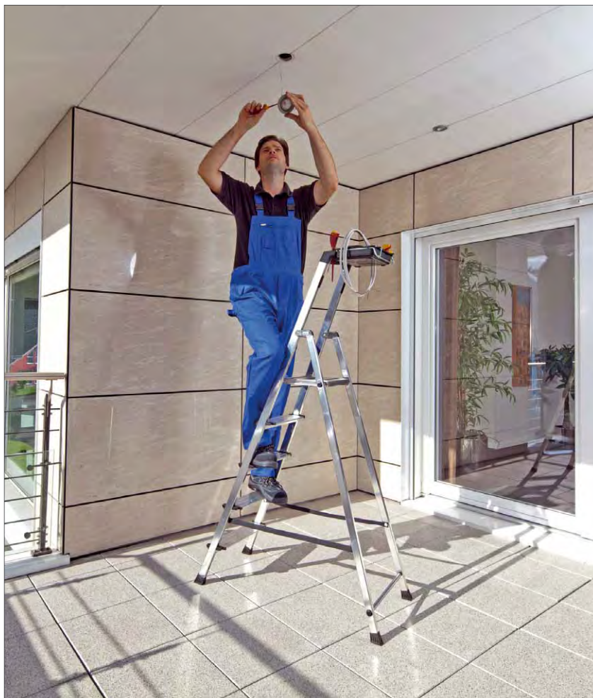
Gerade bei Überkopf-Arbeiten ist ein sicherer Stand extrem wichtig
