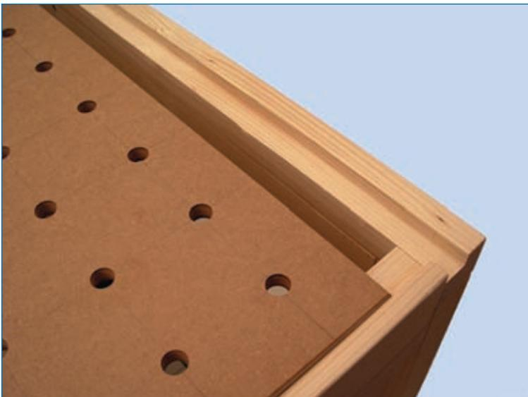
**Abb. 4.4.3:** Die Arbeitsplatte liegt dank der Falze so sicher auf, dass sie nicht einmal verschraubt werden muss.
