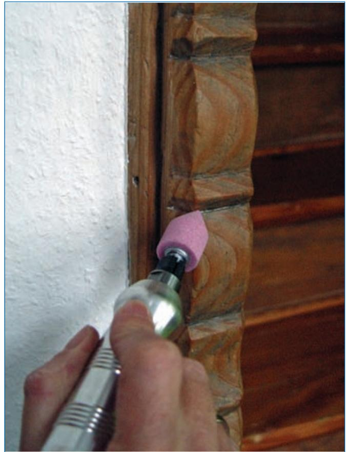
**Abb. 4.7.1:** Mithilfe einer Biegewelle kann man auch an schwer zugänglichen Stellen schleifen.
