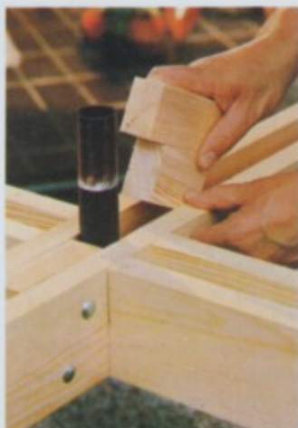
De dikte van de afstandstukken hangt af van de diameter van de asbuis. Hier ziet u de houtverbinding op het kruispunt.
