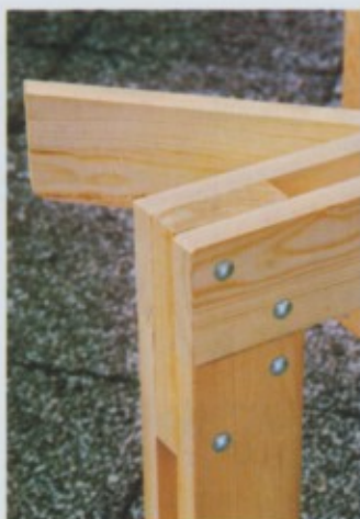
De hoekverbinding van het onderstel met de bouten. Hierop de kopmoeren.
