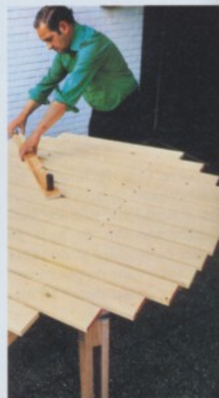
De lipverbinding van de schoren wordt op het gemonteerde onderstel afgetekend en met een fijne zaag uitgezaagd.
