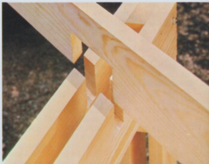
De lipverbinding van de schoren wordt op het gemonteerde onderstel afgetekend en met een fijne zaag uitgezaagd.
