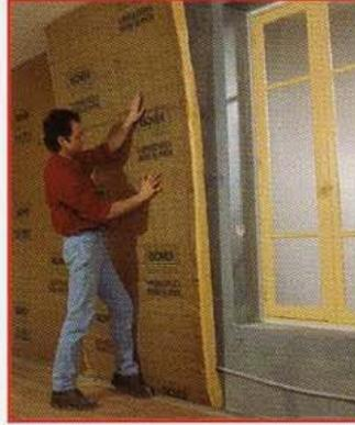
**2** Mesurez la hauteur du mur à isoler et majorez la cote de 2 à 3 cm pour que les lés soient légèrement comprimés. Découpez les lés en série au cutter. Mesurez et coupez les profilés métalliques. Insérez l'isolant dans chaque intervalle. Emboîtez et vissez les profilés pour maintenir l'isolant.
