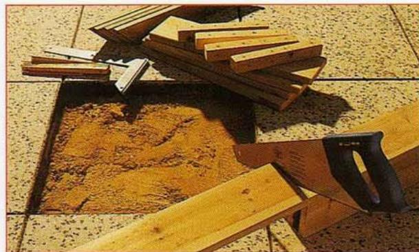
**2** L'emplacement étant dégagé, prenez les mesures et coupez les planches formant les côtés. Taillez aussi les quatre tasseaux de 30 x 30 prenant place à chaque coin. Percez-les de 8 avant-trous  $\varnothing 4$  (4 par face visible) en les décalant légèrement les uns par rapport aux autres.
