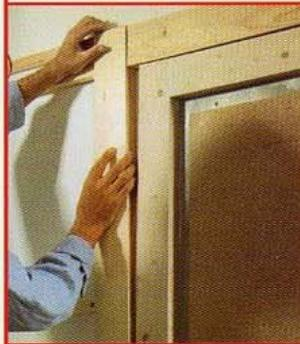
**5** Terminez en collant et pointant les éléments de finition qui couvrent les tasseaux d'ossature périphérique.
