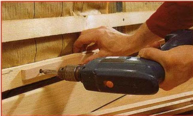
**4** Vissez les tasseaux de fixation des plinthes. Vérifiez le bon alignement horizontal au niveau à bulle. Encollez la rainure des plinthes avec le mastic-colle et emboîtez celles-ci sur les tasseaux de fixation avec un maillet et une cale. Faites de même pour la surplinthe, sur la seconde rangée de tasseaux.
