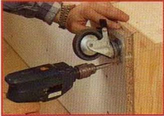
**6** Fixez les platines des quatre roulettes (vis selon le diamètre des trous de la platine).
