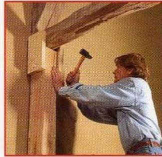
**8** Bloquez le poteau **A** à l'aide de deux chutes de planches clouées latéralement dans l'entrait puis dans le poteau. N'enfoncez pas complètement les clous pour pouvoir les retirer facilement lorsque l'assemblage sera au point (voir cliché 12).
