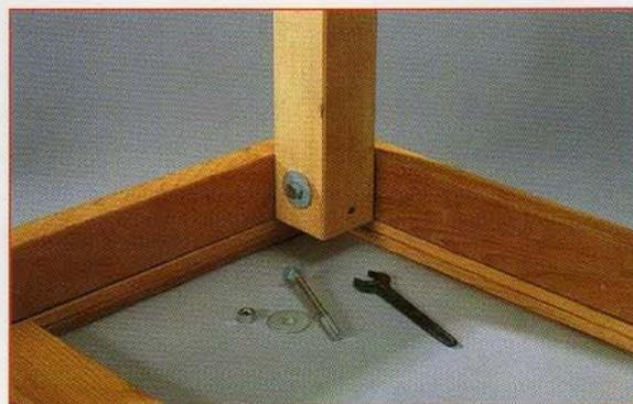
**11** Sur l'autre face, décalez le deuxième perçage vers le bas. Introduisez l'un des boulons TRCC  $\varnothing 10$  et sa rondelle plate, puis son écrou. Serrez fermement mais sans excès avec la clé plate correspondante.
