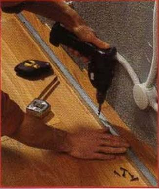
**1** Repérez la position des profilés hauts et bas de l'ossature métallique. Vissez-chevillez au plafond le profilé du haut, puis déterminez l'aplomb au sol avec le fil à plomb pour fixer celui du bas ; celui-ci sera simplement vissé si le sol est recouvert de parquet. Dans tous les autres cas, utilisez des chevilles.
