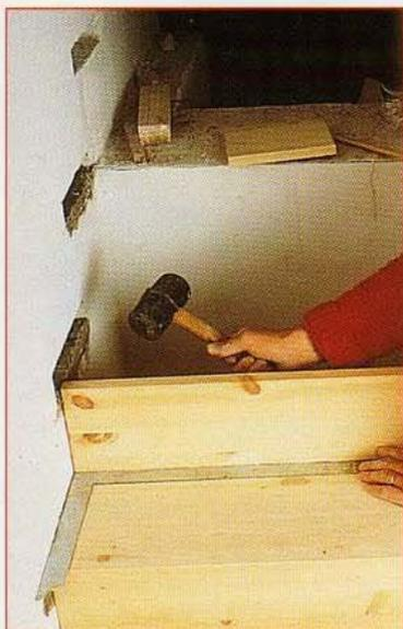
**4** Le temps de prise de la colle (20 mn environ) vous laisse la possibilité d'ajuster la position des éléments. Contrôlez notamment l'équerrage des contre-marches par rapport au mur d'appui.
