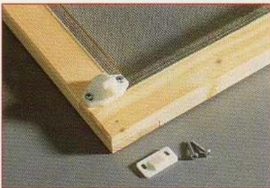
**3** Vissez les taquets de fermeture en plastique sur la porte de gauche (vis à tête plate Ø 3 x 15). Celle de droite tenant fermée grâce au tasseau de blocage de 5 x 35 vissé sur son envers avec des vis à tête fraisée Ø 3 x 20 (photo 4).
