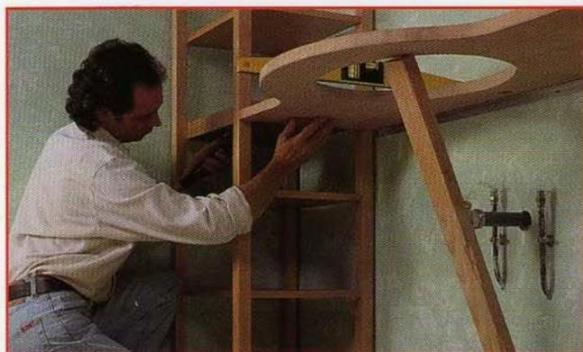
**4** Posez le plan-support **A** sur le profilé fixé au mur. Maintenez l'avant de la vasque en bloquant un tasseau contre la plinthe. Percez les trous des chevilles dans les faces latérales de montants **D** (percez d'abord au  $\varnothing 5$ , puis 10 pour ne pas éclater le montant). Encollez les tourillons  $\varnothing 10$  et enfoncez-les dans les trous avec le maillet et la cale. Laissez le tasseau de blocage, le temps que la colle sèche.
