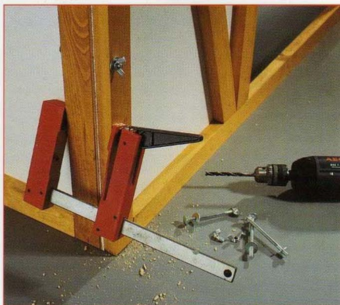
ensuite avec un foret Ø 6 les montants extérieurs des deux éléments, à 20 cm de leur extrémité inférieure. Glissez par l'arrière un boulon TRCC (Ø 6 x 80), ajoutez rondelle et écrou papillon. Répétez l'opération à 10 cm du haut des montants.
