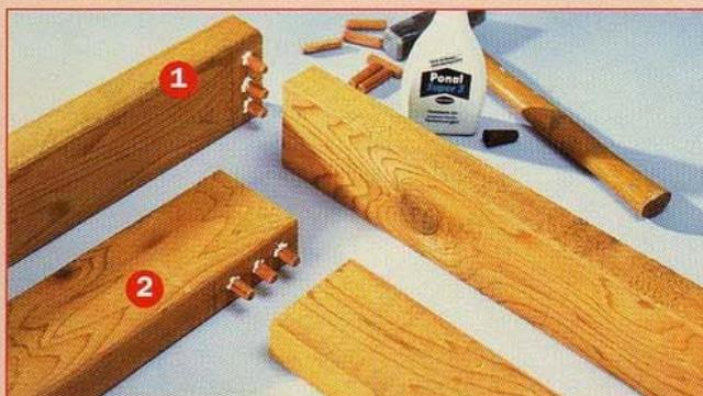
traverses du piétement et plateau, tracez les coupes à l'équerre et effectuez-les à la scie sauteuse ou égoïne. Percez les trous des trois tourillons (avec un foret Ø 10 et sa butée de profondeur) au bout des traverses transversales du plateau et du piétement. Coiffez les trous avec les centreurs et appuyez-y l'extrémité des traverses longitudinales correspondantes en veillant à bien aligner les chants des éléments. Encollez puis assemblez.
