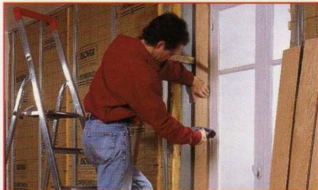
**8** Mesurez et coupez les lames nécessaires à l'habillage du côté gauche du tableau. Un ajustement latéral sera certainement nécessaire pour adapter la largeur de l'habillage à la largeur du tableau : faites cette recoupe latérale de préférence sur la lame du fond (près de la fenêtre). Fixez toutes les lames. Faites de même pour le côté droit du tableau.
