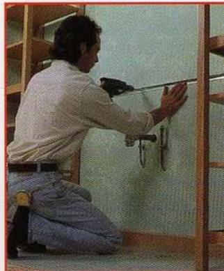
**2** Vérifiez la dimension entre les deux colonnes mises en place : coupez une cornière (scie à métaux) à la dimension. Percez des trous ( $\varnothing 5$ ) sur les deux faces. Tracez au mur l'emplacement de la cornière (niveau à bulle). Percez le mur ( $\varnothing 6$ ). Vissez le profilé (chevilles et vis à bois  $\varnothing 5 \times 60$ ).
