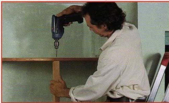
**7** Contrôlez l'intervalle qui sépare le dessus des colonnes et l'emplacement de l'étagère haute. Recoupez si nécessaire les montants complémentaires **G**. Fixez ces derniers à l'aplomb des montants **D** : la partie inférieure par tourillonnage ( $\varnothing$  30), la partie supérieure par vissage (vis agglo  $\varnothing$  4 x 40). Pensez à encoller les deux sections à la colle vinylique avant fixation.
