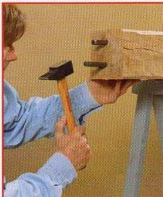
**6** Enfoncez délicatement à mi-longueur les sections de fer rond **G** diam. 12 x 120 dans les deux trous percés dans le poteau **A**. Puis fabriquez la mortaise qui accueillera le tenon de la sole **C**.
