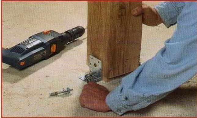
**13** Repérez au sol la position des équerres de fixation **F** des poteaux **A** et **B**. Percez les trous des goujons d'ancrage (perforateur et foret à béton diam. 10). Introduisez les goujons, placez les équerres **F** et serrez les écrous de 17. Clouez les équerres dans les poteaux avec des pointes torsadées (3 x 70). Faites-vous aider pour maintenir la base de chaque poteau pendant que vous clouez, afin qu'il garde sa bonne position.
