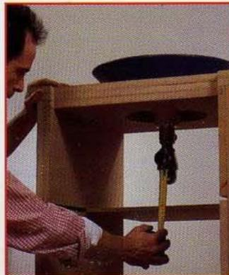
**7** Au fond de la vasque, vissez la bonde, puis le siphon. Posez la vasque dans sa découpe : vérifiez l'encombrement du siphon par rapport à l'étagère supérieure **H**. Si nécessaire, faites une découpe sur l'arrière de la tablette à la scie-cloche ou à la scie-sauteuse.
