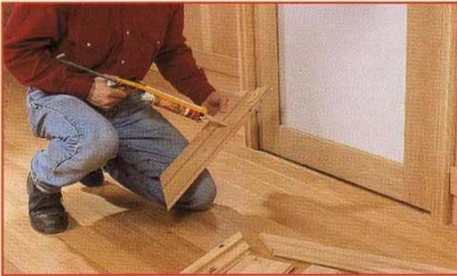
**2** Pendant le séchage de l'entourage, préparez le panneau décoratif inférieur. Mesurez et découpez d'abord 4 morceaux de pilastres pour former le cadre. Puis mesurez et découpez des lames de lambris pour le remplissage. Pour éviter toute erreur, disposez l'ensemble sur le sol, chaque élément devant être bien positionné. Faites un repère au crayon sur l'envers de chaque pièce pour ne pas ensuite les mélanger.
