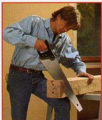
**5** Posez le poteau **A** sur des tréteaux. Percez deux trous parallèles diam. 12 x 60, espacés de 70 mm. Pour un intervalle constant entre ces trous sur toutes les pièces, aidez-vous d'un gabarit. Prolongez le tracé sur les deux faces verticales pour une coupe perpendiculaire à la scie égoïne.
