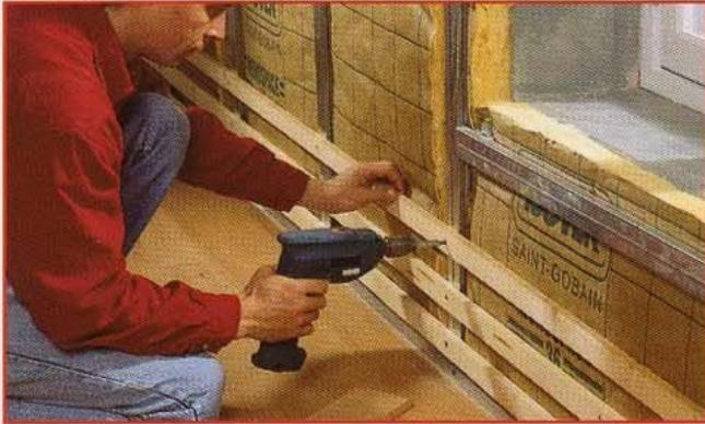
**3** Fixez un profilé métallique horizontal sous l'appui de fenêtre. L'ossature métallique et l'isolant sont maintenant posés. Commencez à couper et visser les tasseaux d'ossature en prévision des tasseaux de plinthe et contre-plinthe. Procédez de même pour les tasseaux permettant de fixer la partie haute des lames du soubassement. (Voir photo 9).
