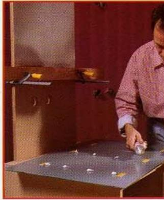
**12** Fixez, avec les serre-joints, un tasseau sous le trait inférieur de l'emplacement du miroir, pour créer un guide de mise en place et une butée, le temps du séchage du mastic-colle du miroir. Placez de l'adhésif double-face en six points de l'envers du miroir. Complétez par des plots de mastic-colle.
