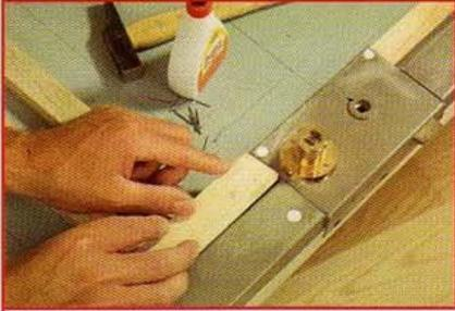
**1** Commencez par le tasseau **B** qui se place de part et d'autre de la serrure. Maintenez-en les deux parties à l'aide de serre-joints. Percez des avant-trous diam. 4 à travers les tasseaux et le blindage. Fraisez puis vissez.
