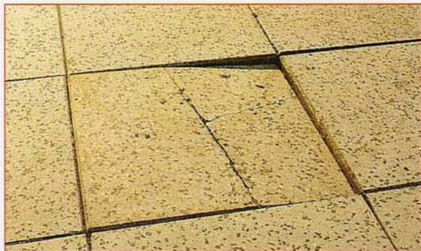
**1** Si nécessaire, enlevez d'abord les dalles situées à la périphérie du ou des éléments endommagés. Faites sauter leurs joints au burin en veillant à ne pas abîmer les surfaces. Retirez la ou les dalles cassées ou fendues et replacez celles du pourtour en refaisant leurs joints.
