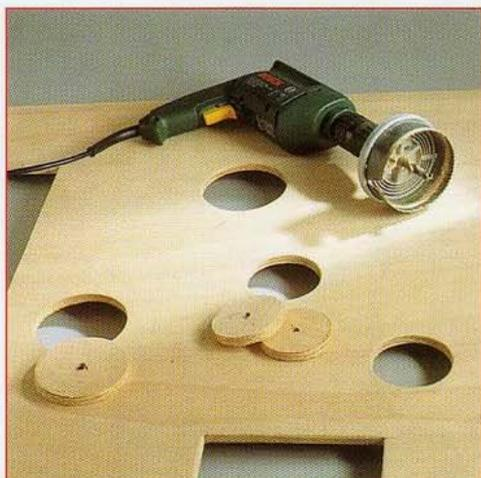
**3** Les trous de la façade se percent avec des lames de deux diamètres différents : 80 et 95 mm (voir dessin).
