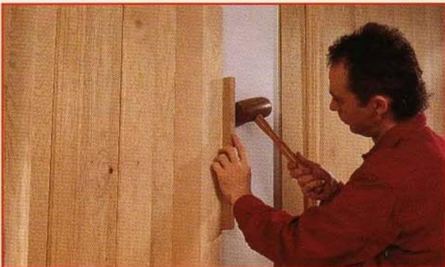
**4** Le panneau décoratif supérieur se réalise de la même façon : les éléments verticaux du cadre (pilastres) et les lames de remplissage (lambris) sont plus longs. Procédez dans le même ordre que pour le panneau inférieur : la traverse inférieure, le montant de cadre gauche ou droit, puis les lames intérieures, le deuxième montant vertical et enfin, la traverse supérieure.
