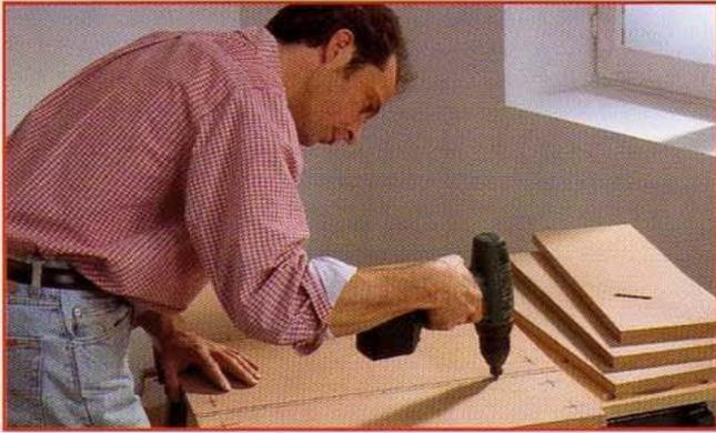
**1** Posez à plat sur l'établi un des deux côtés intermédiaires **E** : tracez à l'équerre l'emplacement des deux tablettes, soit des parallèles espacées de 150 mm (espace du sol à la 1<sup>re</sup> tablette), 16 mm (ép. tablette), 280 mm (espace entre tablettes), 16 mm (ép. tablette). Tracez et percez quatre avant-trous (diam. 3) par panneau, puis deux avant-trous (diam. 3) par espacement de 16 mm, ceux-ci pour la fixation ultérieure des côtés extérieurs **D**.
