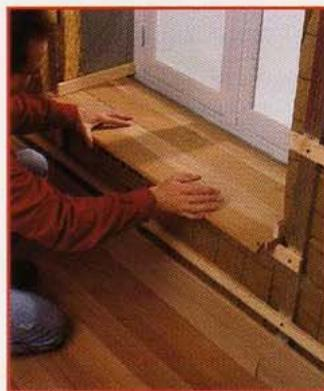
**6** Posez les lames de l'appui de fenêtre en les glissant sous les tasseaux d'ossature inférieurs. Ces lames ne sont pas fixées individuellement, mais retenues à l'avant par la dernière lame posée qui a un profil particulier lui permettant de se coller en appui sur le tasseau d'ossature.
