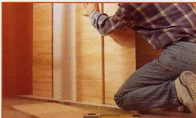
**3** Présentez chacun des quatre parements **F** sur la façade **C** : vérifiez le bon ajustement, rectifiez si nécessaire. Encollez (colle néoprène) les quatre parements **F** et la façade **C** (hors joints creux). Plaquez chaque parement en vous servant d'une chute de tasseau ou de planche d'ép. 20 mm pour respecter l'écartement. Complétez la fixation par des vis (4 x 30) fixées par l'intérieur du panneau **C**. La tranche des côtés **C** sera masquée par ces parements.
