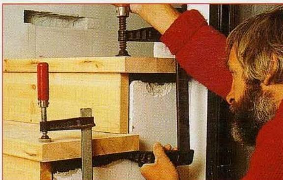
**5** Lorsque les éléments de deux marches sont à la bonne place, mettez-les sous presse et passez aux suivants. Un scellement au ciment rapide est considéré comme fiable après 20 mn, mais il est préférable d'attendre 2 h.
