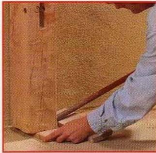
**7** Engagez le poteau **A** en biais pour que les fers rentrent aisément dans leurs logements. Soulevez ensuite le poteau en faisant levier avec la pince à décoffrer ou la barre à mine et placez la cale **D** sous le poteau.
