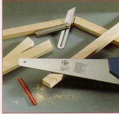
**2** et 2 bis. Tracez l'emplacement des tasseaux imitant les colombages sur les parois en utilisant un tasseau (bien droit !) et le dessin. Mesurez ensuite les longueurs à prévoir et recoupez les éléments après les avoir tracés à l'équerre (coupes droites) ou à la fausse-équerre (coupes obliques).
