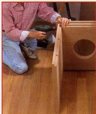
**6** Placez le plateau supérieur **A, B, C** sur son chant arrière. Présentez un des côtés **E, F**, soit en vous appuyant contre un mur, soit en vous faisant aider pour maintenir l'assemblage. Percez des avant-trous fraisés ( $\varnothing$  5). Vissez (vis agglo  $\varnothing$  5 x 60) chaque ensemble **E + F1 + F2 + F3**.
