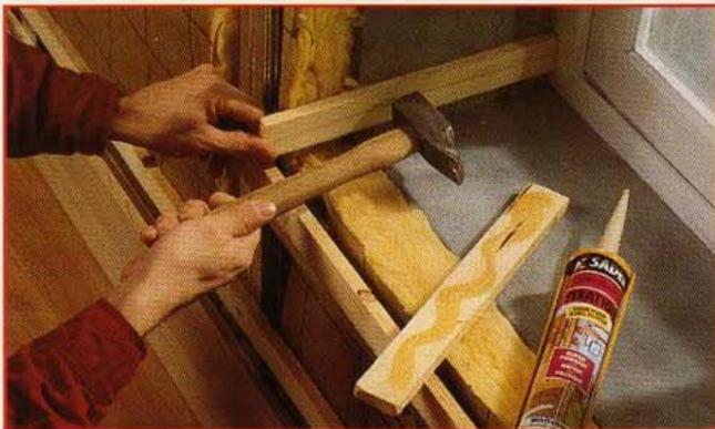
**5** Démarrez la pose des tasseaux d'ossature du tableau par le bas des côtés, en laissant l'épaisseur d'une lame sous les tasseaux. Découpez et fixez au mastic-colle trois à quatre tasseaux suivant la hauteur de l'encadrement de fenêtre.
