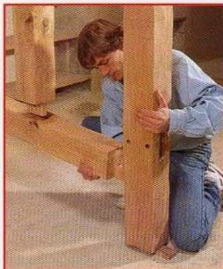
**11** Engagez le tenon de la sole **C** dans le poteau de départ **A**, puis ceux des deux colombages **E'** dans la sole **C**. Emboîtez la mortaise du poteau **B** sur l'autre tenon de la sole **C**. Faites de même pour les deux colombages **E'** et la sole **C'** fixée dans le poteau existant (équerre de charpente).
