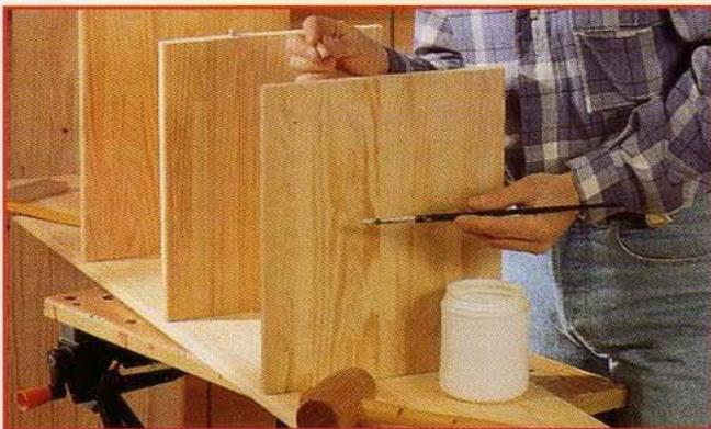
**8** L'assemblage des éléments **I** et **J** se réalise par collage et tourillonnage (deux tourillons par chant de tablette). Chaque étagère **J** est espacée de 50 cm. Repérez et percez les trous de tourillon (diam. 8) dans les chants et sur les faces intérieures des côtés. Collez (colle vinylique), et assemblez à l'aide du maillet et de la cale.
