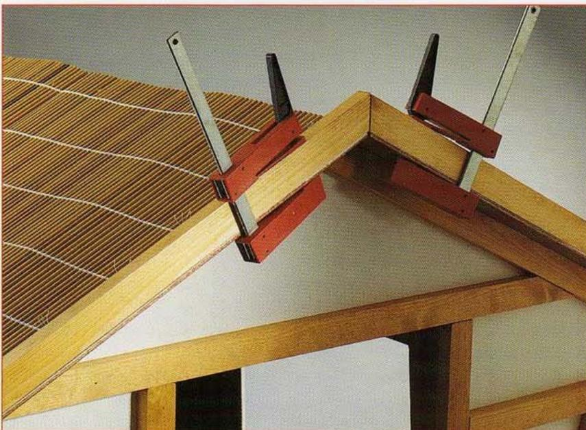
**9** Le toit peut être peint, garni de bardeaux bitumeux ou recouvert de canisses en plastique. Ceux-ci sont alors agrafés sur les panneaux et leurs bords, fixés sous les tasseaux qui garnissent l'avant et l'arrière du toit (E2). Serrez ces derniers à leur place avec deux serre-joints et vissez-les par dessous (vis agglo Ø 3 x 20) à travers des avant-trous Ø 3. Viendront ensuite finir le bord du toit des tasseaux (E3) qui seront fixés par clous sur ceux de rives (E2).
