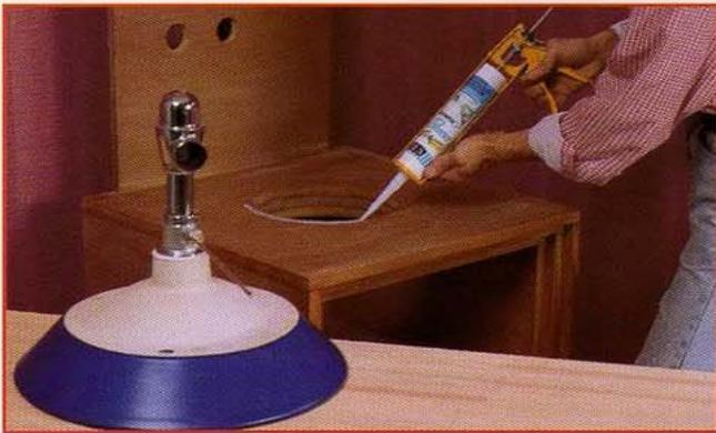
**15** Déposez un cordon de mastic-silicone de 5 mm de large environ tout autour de la découpe sur le plateau **A, B, C**. Posez la vasque (sans la faire tourner sur elle-même). Exercez une pression sur ses bords pendant quelques secondes pour assurer le collage et l'étanchéité. **Attention !** si la vasque est équipée d'un trop-plein, assurez-vous de la bonne orientation de son orifice.
