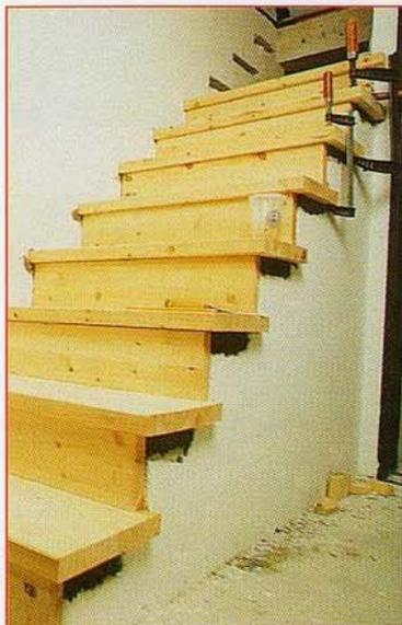
**7** Dès que la colle est sèche (24 h au minimum), retirez les serre-joints et protégez le bord des marches et contre-marches par du ruban de masquage.
