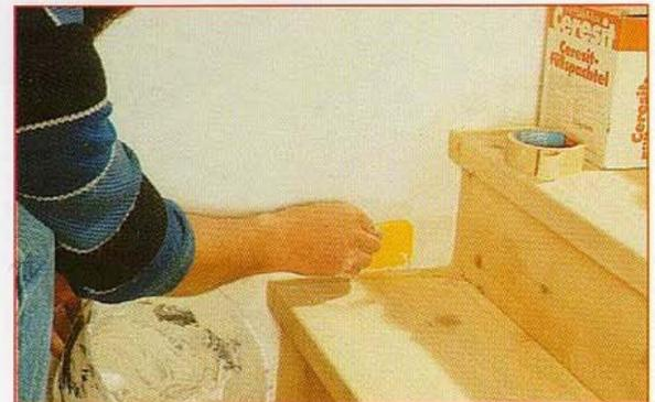
**8** Comblez les manques au ras des marches, et autres cavités de la maçonnerie, avec de l'enduit de rebouchage. La construction de l'escalier étant terminée, reste la finition des surfaces.
