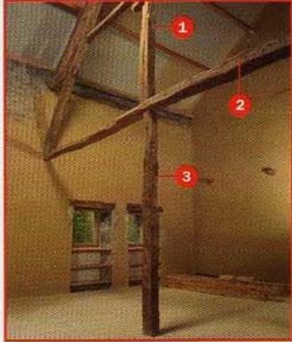
**1** La poutraison d'origine comporte un poinçon **1** (vertical) reposant sur un entrait **2** (horizontal), soutenu par un poteau **3** de 130 x 150. La séparation en colombages s'implante entre ce poteau et le mur de gauche.
