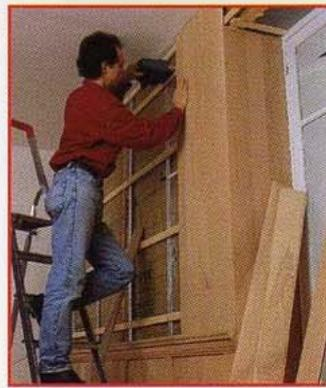
**11** Habillez ensuite la partie supérieure du mur qui sera composée de lames sans pilastre. Cette pose, plus rapide, se terminera par le collage des corniches au ras du plafond.
