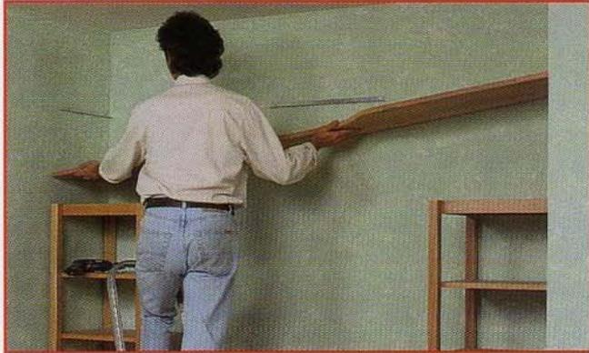
**6** Tracez au mur (à 300 mm du haut des montants) l'emplacement de la partie basse de la cornière qui fixera l'étagère haute **B**. Servez-vous du niveau à bulle pour vérifier l'horizontalité des tracés du fond et des côtés. Coupez la cornière et utilisez les chutes des deux autres pour les morceaux latéraux (long. 200 mm). Percez ( $\varnothing$  3) sur les deux faces. Fixez l'étagère haute comme les deux précédentes.
