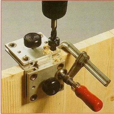
**1** Sur les chants des côtés, dessus, dessous et tablettes fixes, repérez les emplacements des trous à percer pour les tourillons. Équipez votre foret  $\varnothing 8$  d'une butée de profondeur et utilisez un guide à tourillons.
