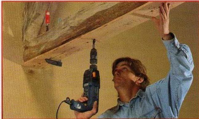
**3** Percez dans l'entrait les logements des tiges de fixation des poteaux **A** et **B** et des colombages **E** et **E'** : utilisez un gabarit fait d'une planche en contreplaqué ép. 10 mm percée (diam. 12) aux endroits voulus. Maintenez (à l'aide de serre-joints) ce gabarit à chaque extrémité de l'entrait, milieu des percements sur milieu de l'entrait, et servez-vous d'un support de perçage mobile pour que les percements soient bien perpendiculaires.
