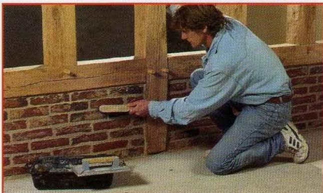
**15** Préparez le mortier blanc. Bourrez les joints avec du ciment blanc à l'aide d'un fer à joints. Quand le mortier commence à prendre, brossez la surface de l'appareillage avec une balayette. Nettoyez à l'eau la face des briques pour éliminer les bavures de mortier. Répétez ce nettoyage plusieurs fois. Lavez l'auge à grande eau sans attendre que le mortier sèche.
