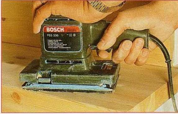
**9** Après séchage de l'enduit, poncez soigneusement les surfaces murales ainsi que les faces et chants des marches et contre-marches. Grâce à sa semelle rectangulaire, une ponceuse vibrante est la plus indiquée. Commencez avec un abrasif à grain moyen (240) puis fin (400). Dépoussiérez à fond les surfaces avant de les vitrifier.
