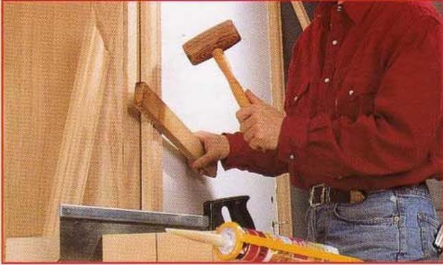
**1** Si vous pouvez dégondrer la porte, vous travaillerez plus facilement en la posant sur 2 tréteaux. L'entourage est fait de pilastres. Repérez et tracez sur la porte l'emplacement des montants et de la traverse qui constituent l'entourage. Mesurez et découpez les éléments correspondants (pilastres), puis fixez-les au mastic-colle. Aidez-vous du maillet et de la cale en bois tendre. Maintenez avec des serre-joints et des cales.
