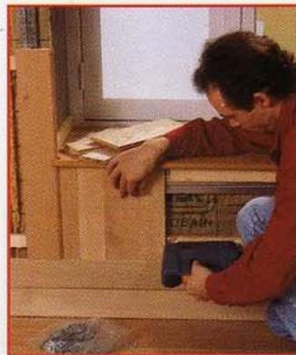
**7** A gauche de la fenêtre, vissez verticalement le tasseau de fixation du premier pilastre. Mesurez, coupez et encollez le pilastre, puis emboîtez-le jusqu'à la sur-plinthe à l'aide du maillet et de la cale. Mesurez, coupez et fixez les lames du soubassement. Faites de même pour le côté droit.
