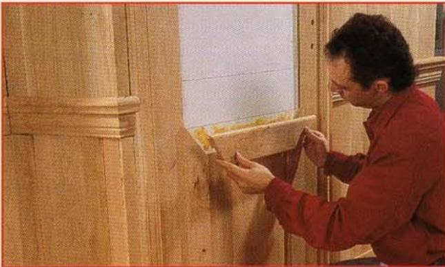
**3** Enlevez les serre-joints de l'entourage. Tracez à l'équerre l'emplacement du panneau décoratif. Encollez les lames une par une au mastic-colle et mettez-les en place successivement en commençant par la traverse inférieure, le montant de cadre gauche ou droit, puis les lames intérieures, le deuxième montant vertical, et enfin, la traverse supérieure. Serrez fortement chaque lame à l'aide du maillet et de la cale. Appuyez bien à chaque fois pour assurer le collage.
