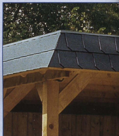
Dachkante mit Aluschiene
