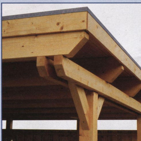
Flachdach: Holzblende mit Aluabschluss; Konstruktion mit Doppelpfette
