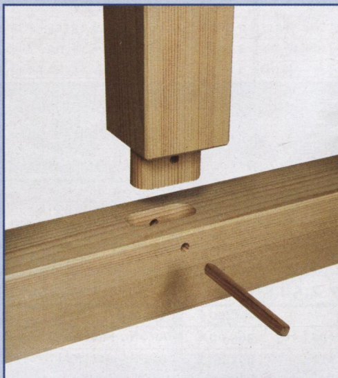
Verbindungen mit Holznägeln
