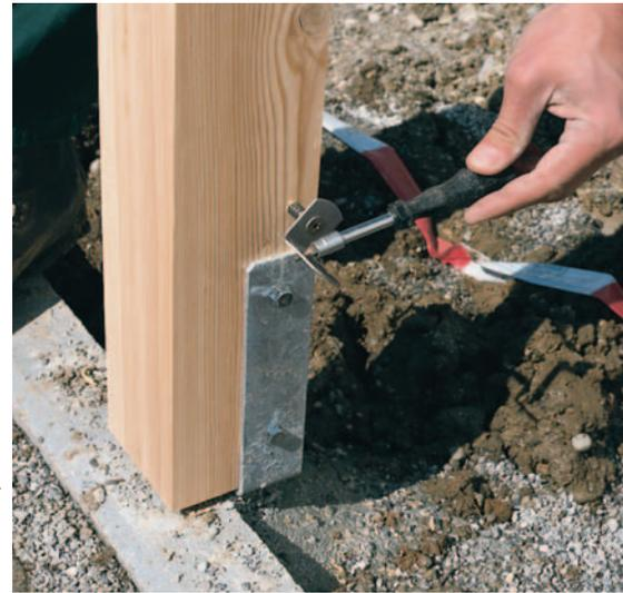
2 Dann werden die Zaunwinkel in die vorgebohrten Löcher eingedreht, ... ▶
