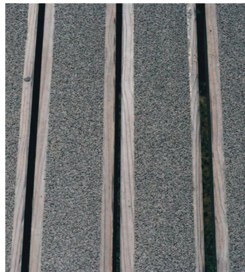
*Bei Nässe sind sandbeschichtete Holzbeläge sicherer zu begehen als Holzbeläge mit gehobelter Oberfläche.*
