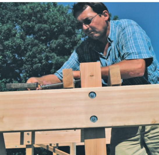
◀ 5 Wenn die Fundamente abgehärtet sind, können die Sparren aufgeschraubt werden.
