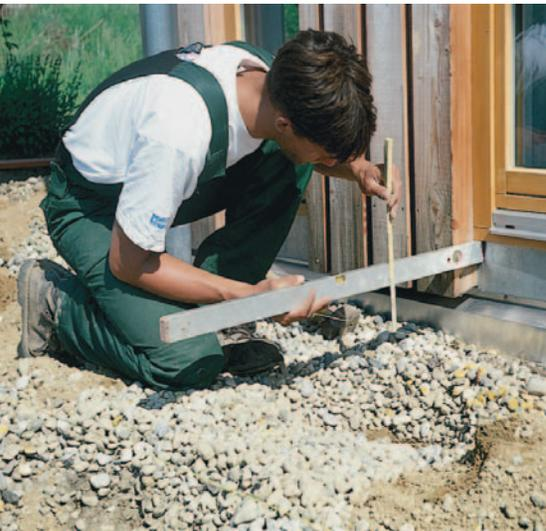
◀ 1 Zunächst müssen die Standorte für die Metallschuhe eingemessen werden. Dabei muss besonders auf die Anschlusshöhen an Türen oder Lichtschächten geachtet werden.
