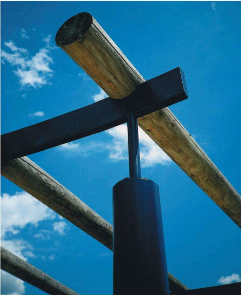
Bei dieser Pergola ist der oben liegende Rundholzsparren auf eine Metallpfette aufgekämmt worden.
