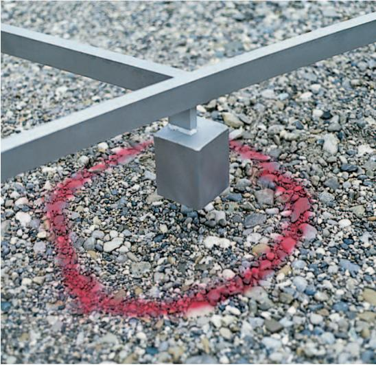
◀ 1 Die Rahmenkonstruktion wird eingemessen und am geplanten Standort auf den Boden gelegt, dann werden die Standorte der Fundamente markiert.
