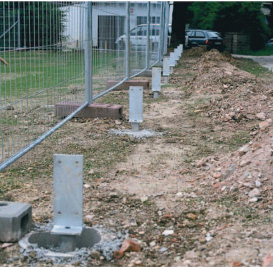
◀ 1 Zunächst müssen die Pfostenschuhe eingemessen und in ein Betonfundament versetzt werden.
