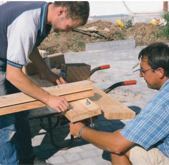
◀ 1 Zunächst werden die Pfetten in einer Zangenkonstruktion mit den Pfosten verschraubt ...
