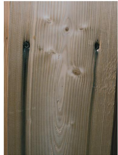
*Metallverbindungen aus nicht witterungsbeständigem Material führen zu Verfärbungen. Da die Verschraubungen nicht vorgebohrt wurden, ist der Rand der Verschraubungen zudem gesplittert.*
