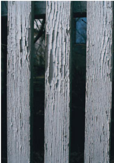
*Nicht nur die Oberflächenbeschichtung, auch das darunter liegende Holz ist von der Witterung stark angegriffen und muss vollständig entfernt werden, bevor ein neuer Anstrich erfolgen kann.*
