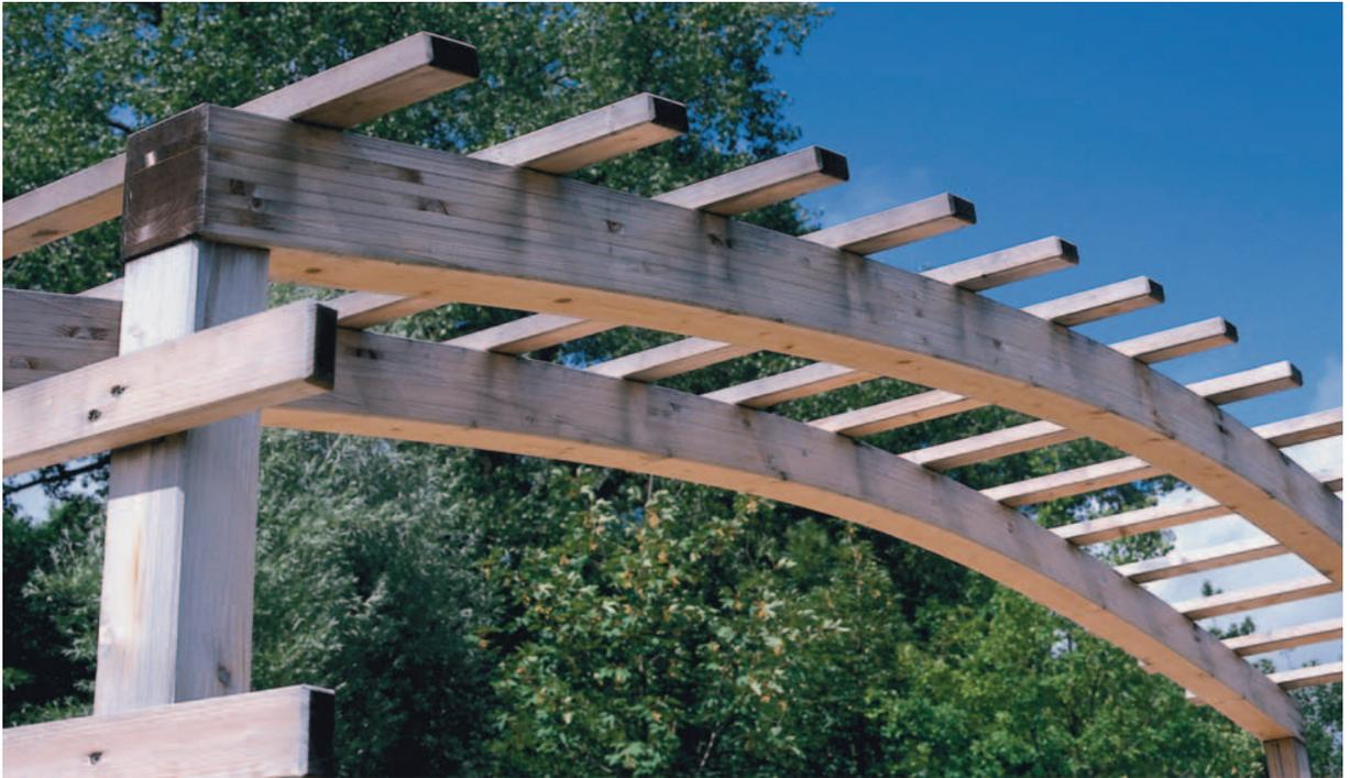
*Für gebogene oder sehr hoch belastete Holzbauteile müssen Brettschichthölzer verwendet werden.*
