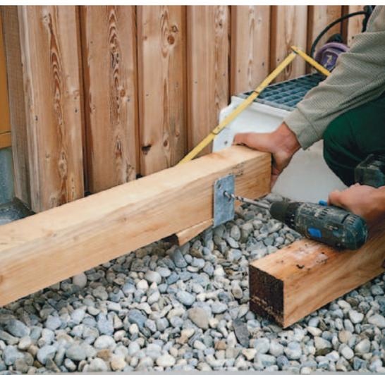
◀ 5 Wenn der Beton ausgehärtet ist, werden die Balken der Unterkonstruktion mit Holzkeilen in die exakte Höhe gebracht und festgeschraubt.
