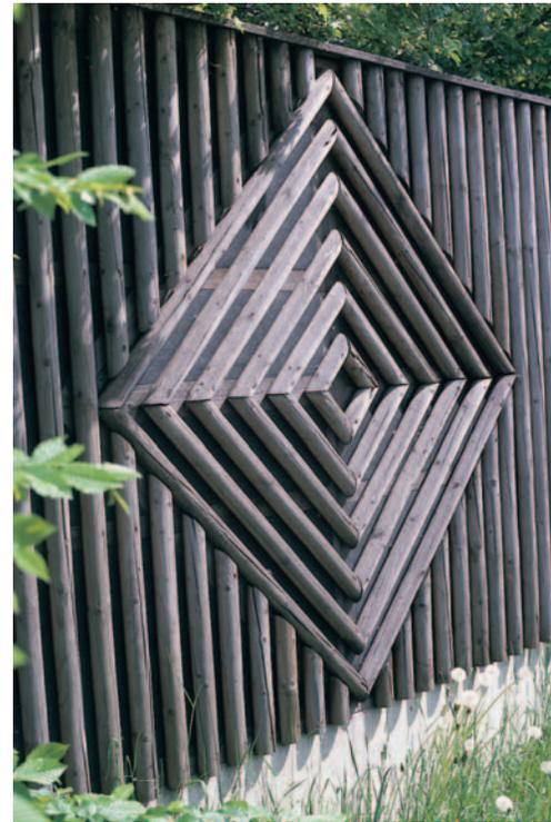
*Die der Lärmquelle zugewandte Seite der Lärmschutzwand wird mit Mineralwolle abgedeckt, die durch ein hölzernes Frontgitter geschützt wird, ...*
