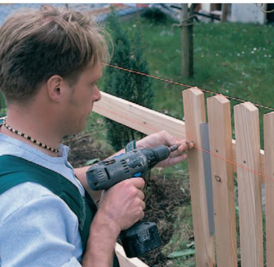
◀ 5 Mit straff gespannten Schnüren wird die Oberkante der Latten markiert, durch einen Abstandhalter wird immer der gleiche Zwischenraum zwischen den Latten eingehalten.
