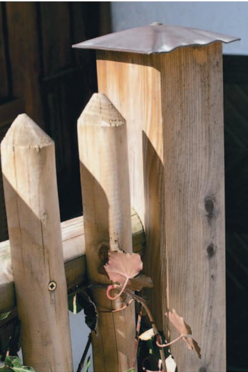
*Ein fachgerecht gebauter Holzzaun mit abgedecktem Pfosten, angespitzten Latten und einer kleinen Kontaktfläche zwischen Latten und Querriegeln kann 25 bis 35 Jahre lang halten.*
