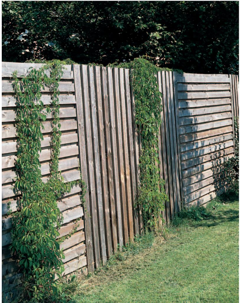
*Auch eine reflektierende Lärm-schutzwand in einer Nut- und Feder-schalung hat sehr hohe Schalldämm-werte.*
