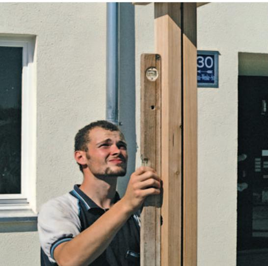
◀ 3 Bevor die Fundamente mit Beton ausgefüllt werden, sind die Pfosten genau senkrecht auszurichten.
