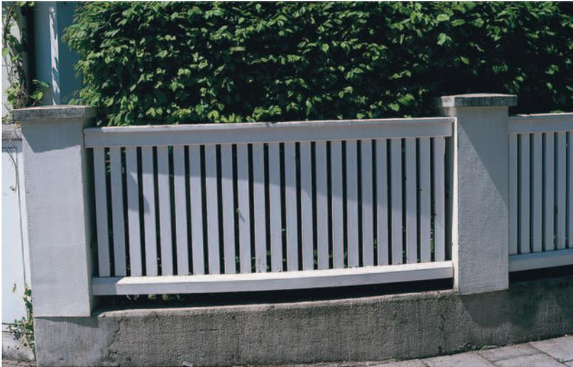
Bei einem Holzrahmenzaun werden die Latten oben und unten zwischen Bohlen befestigt und die Stirnseiten der Latten durch ein Abdeckholz geschützt.
