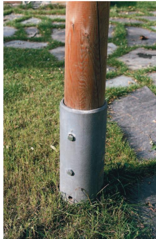
*Da Niederschlagswasser bei diesem Pfostenschuh zwischen Metall und Holz eindringen kann, ist diese Lösung nicht sinnvoll.*
