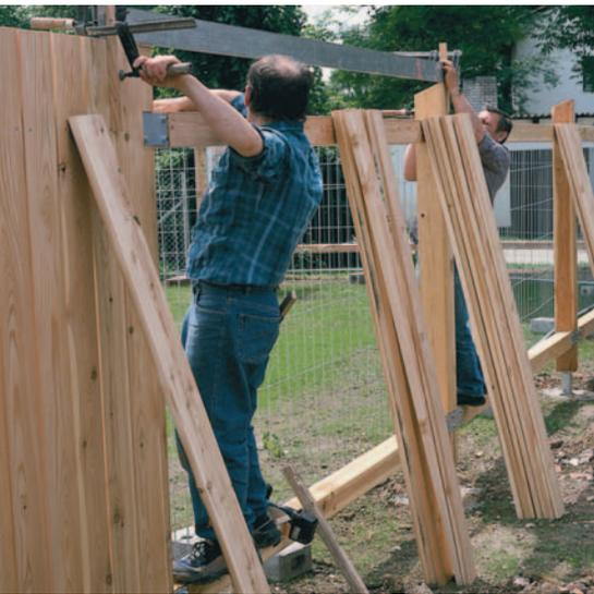
◀ 3 Mit einer Richtlatte aus Metall wird die Oberkante der Bretterwand markiert, ...
