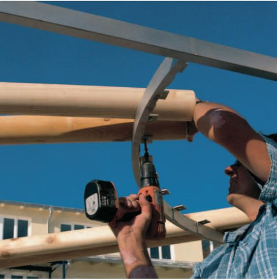
◀ 7 ... und die Sparren können auf den Metallrahmen montiert werden.
