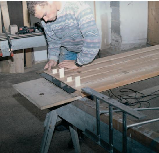
◀ 1 Die Sitzbretter werden mit Hilfe von Abstandshölzern und einem Metallwinkel auf die spätere Breite und Länge ausgerichtet ...
