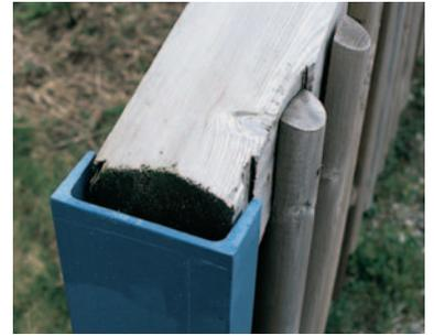
Lärmschutzelemente werden häufig in Stahlpfosten befestigt.
