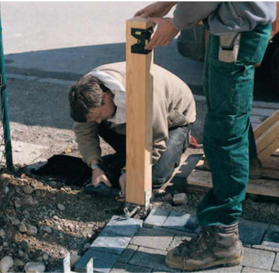
◀ 1 In die bereits einbetonierten Pfostenschuhe werden die Holzpfosten montiert und senkrecht ausgerichtet.
