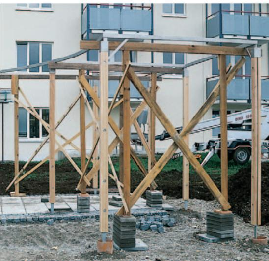
▶ 5 ... und anschließend die Pfostenschuhe einbetoniert.
